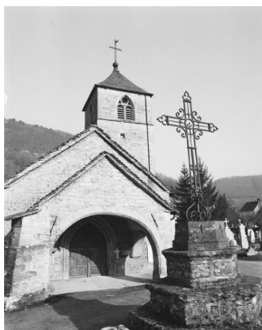
Façade antérieure en 1983. Phot. Yves Sancey IVR43_19833900068X
