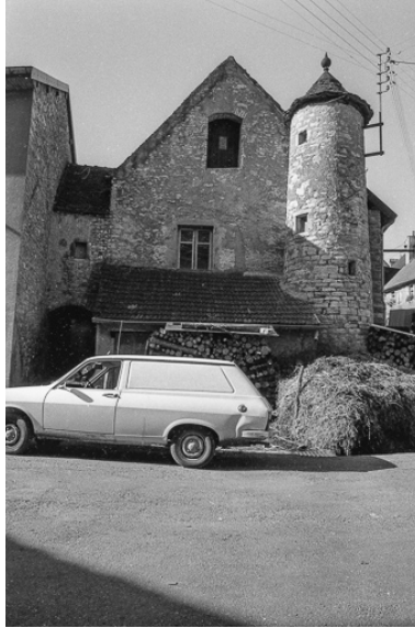
Façade latérale gauche. Phot. Bernard Lardière IVR43_19797000384Z
