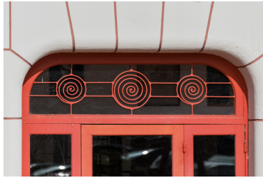
Porte en façade du cinéma : motifs en spirale de l'imposte. Phot. Pierre-Marie Barbe-Richaud IVR26_20235800194NUC4A
