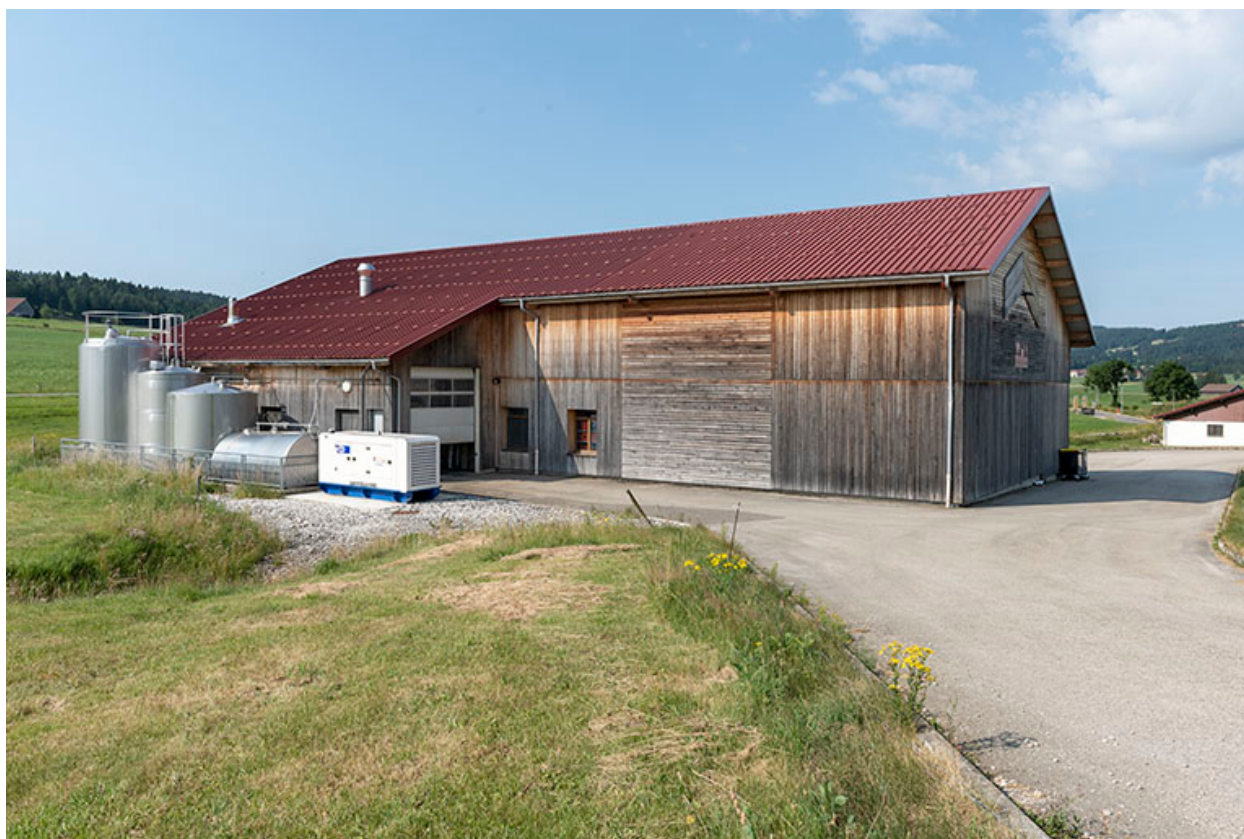
Façades postérieure et latérale droite.
