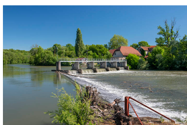
Site du barrage. Phot. Jérôme Mongreville IVR43_20197000353NUC4A
