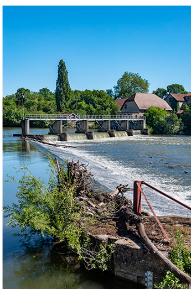
Culée du barrage. Phot. Jérôme Mongreville
