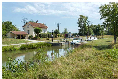
Site d'écluse de Vereux. Phot. Sonia Dourlot IVR43_20157000858NUC4A
