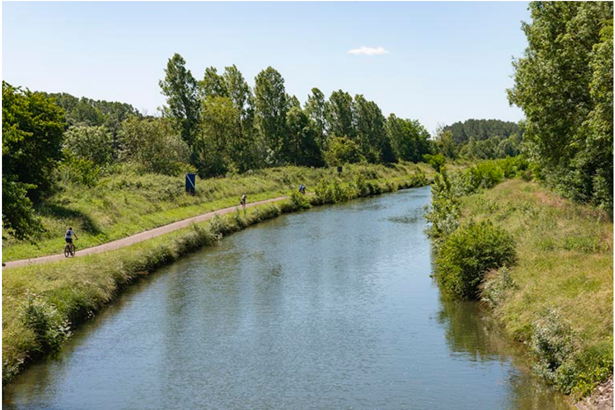
Vue générale de la dérivation.
