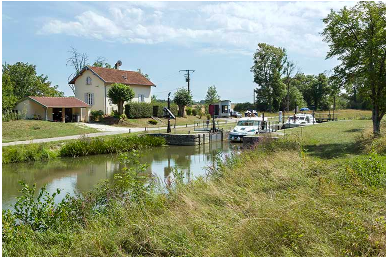
Site d'écluse de Vereux.
