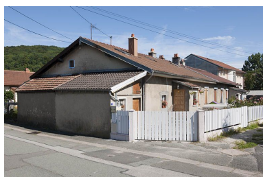
Habitation en rez-de- chaussée vue de trois quarts. Phot. Jérôme Mongreville IVR43_20112502161NUC4A
