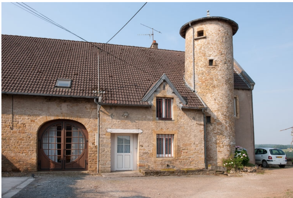
Façade antérieure, vue de trois quart gauche.
