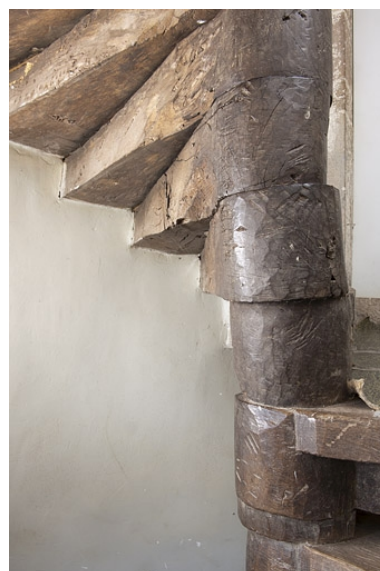
Intérieur : détail de l'escalier en vis menant à l'étage. Phot. Jérôme Mongreville IVR43_20102500336NUC4A
