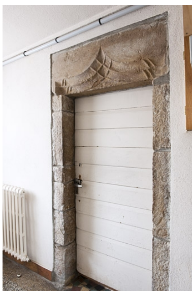
Intérieur : baie conduisant à l'ancienne grange. Phot. Jérôme Mongreville IVR43_20102500326NUC4A
