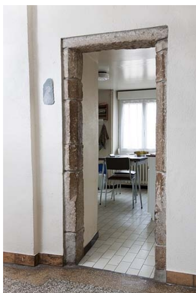
Intérieur : porte aux montants moulurés ouvrant sur la nouvelle cuisine. Phot. Jérôme Mongreville IVR43_20102500328NUC4A
