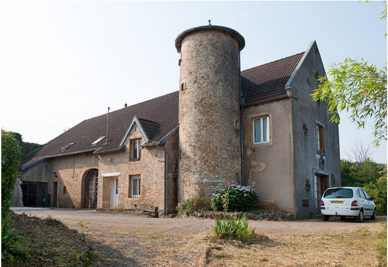
Façade antérieure, vue de trois quart droit.
