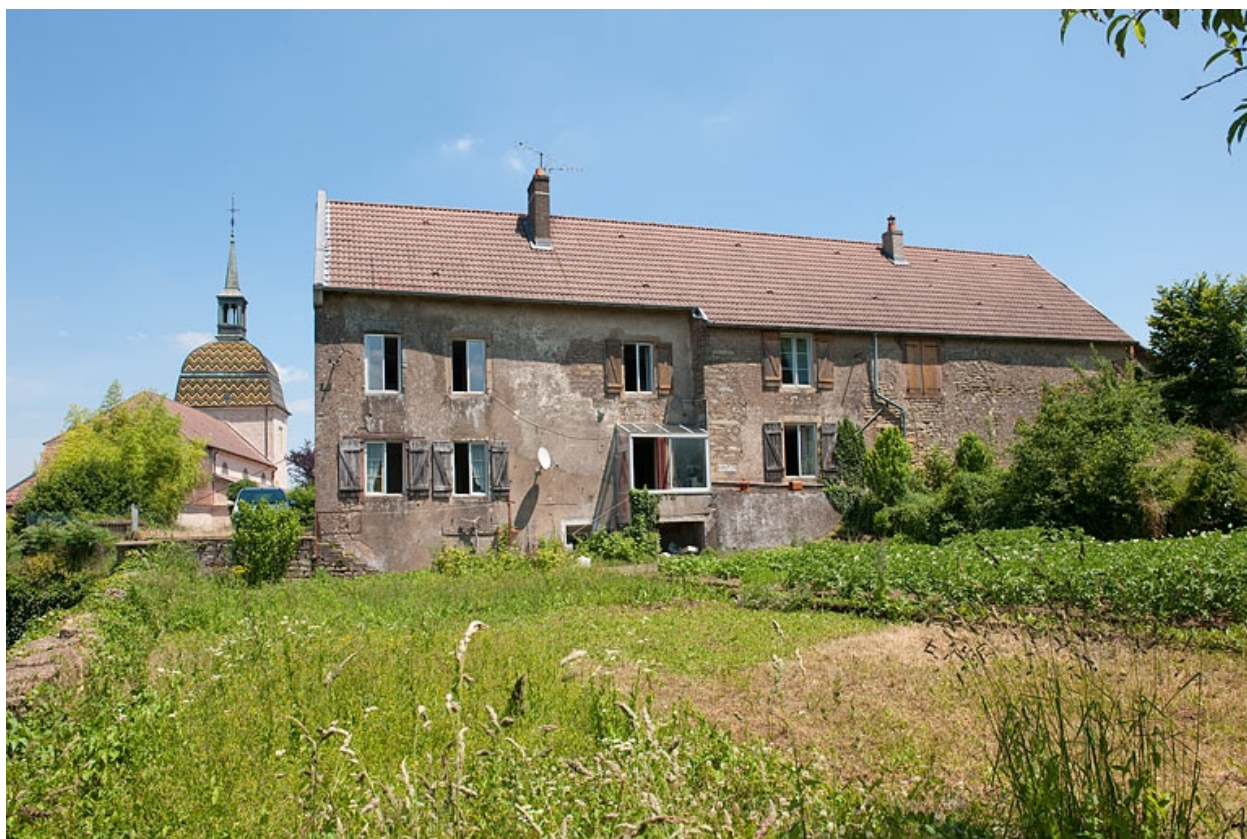
Vue générale de la façade postérieure.
