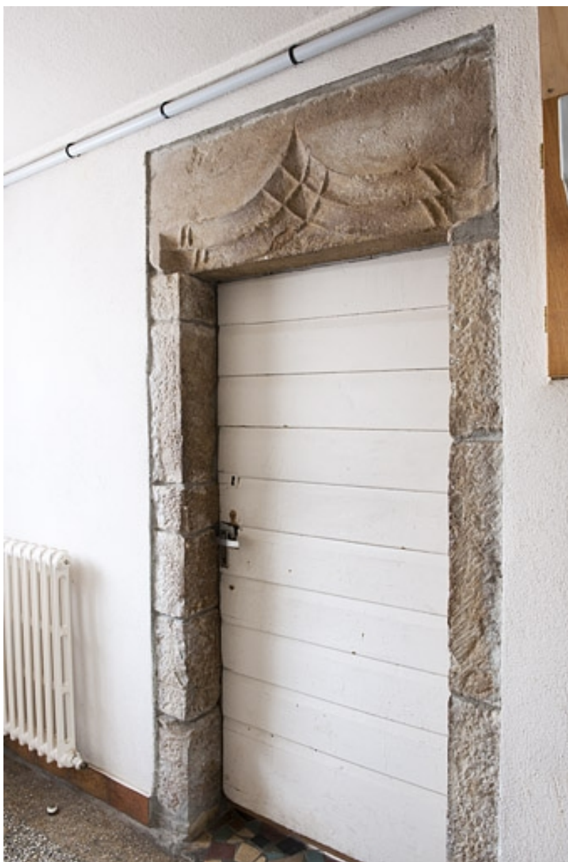
Intérieur : baie conduisant à l'ancienne grange.
