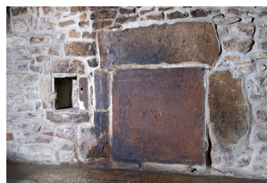
Intérieur : détail de la cheminée. Phot. Jérôme Mongreville IVR43_20102500329NUC4A
