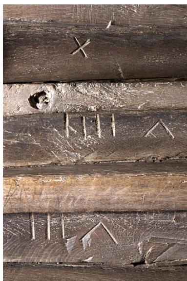
Intérieur : escalier en charpente menant à l'étage, détail des marches numérotées. Phot. Jérôme Mongreville IVR43_20102500334NUC4A
