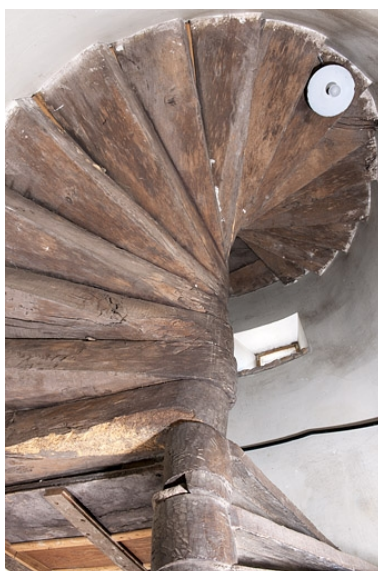
Intérieur : le dessous de l'escalier en vis menant à l'étage. Phot. Jérôme Mongreville IVR43_20102500335NUC4A
