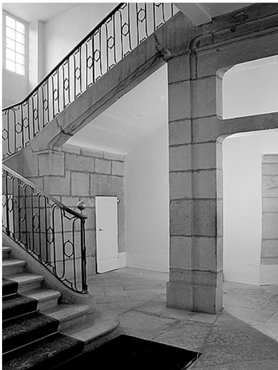
Vestibule et départ de l'escalier.
