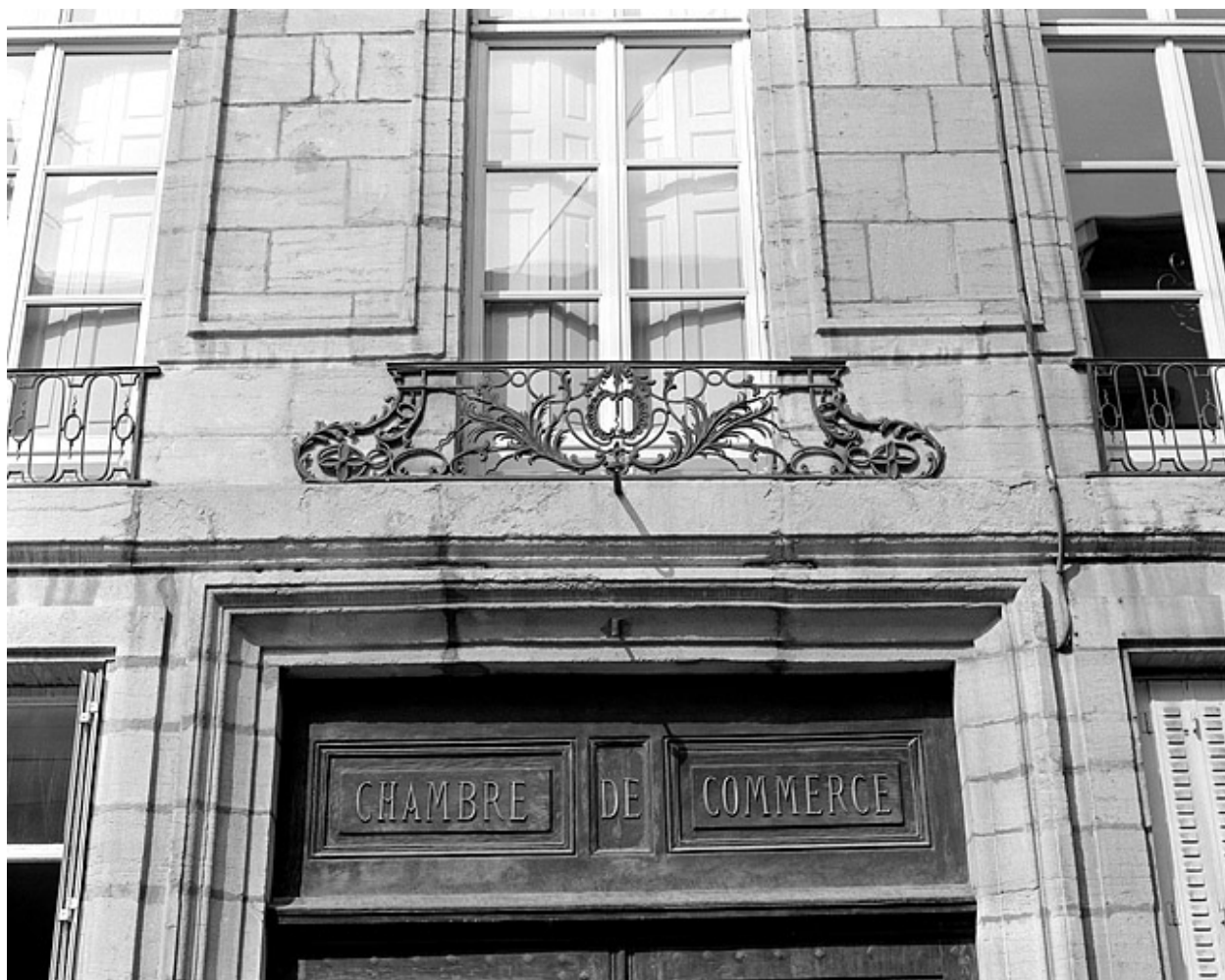
Façade antérieure, garde-corps de la fenêtre centrale.
