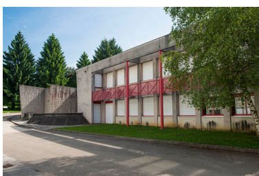
Façade ouest de l'aile occidentale de l'externat.
