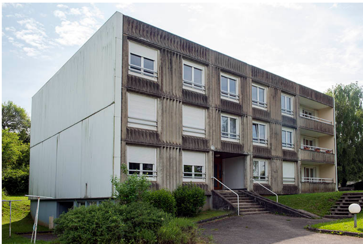
Angle ouest des logements de fonction.
