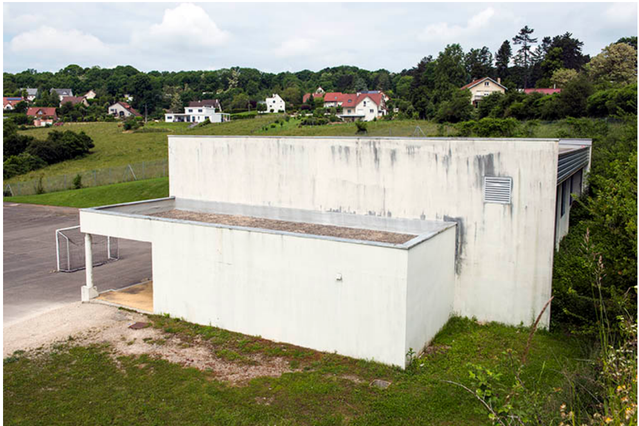
Angle sud-est du gymnase.
