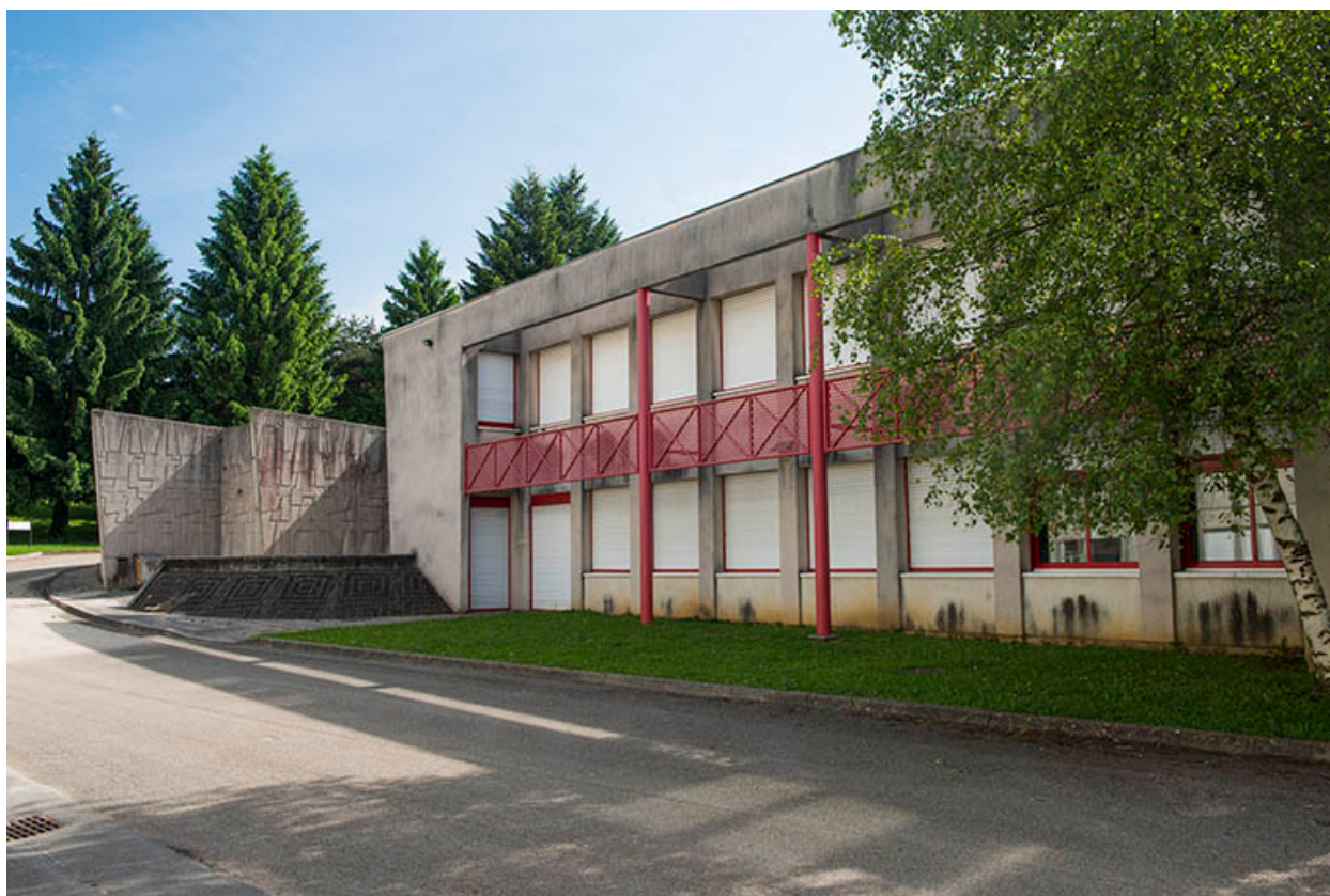
Façade ouest de l'aile occidentale de l'externat.
