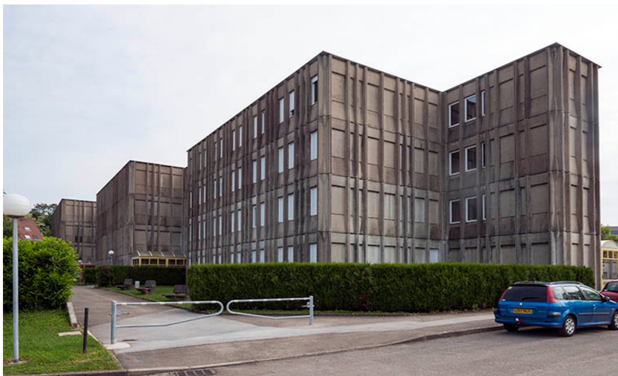
Façade ouest postérieure de l'internat.
