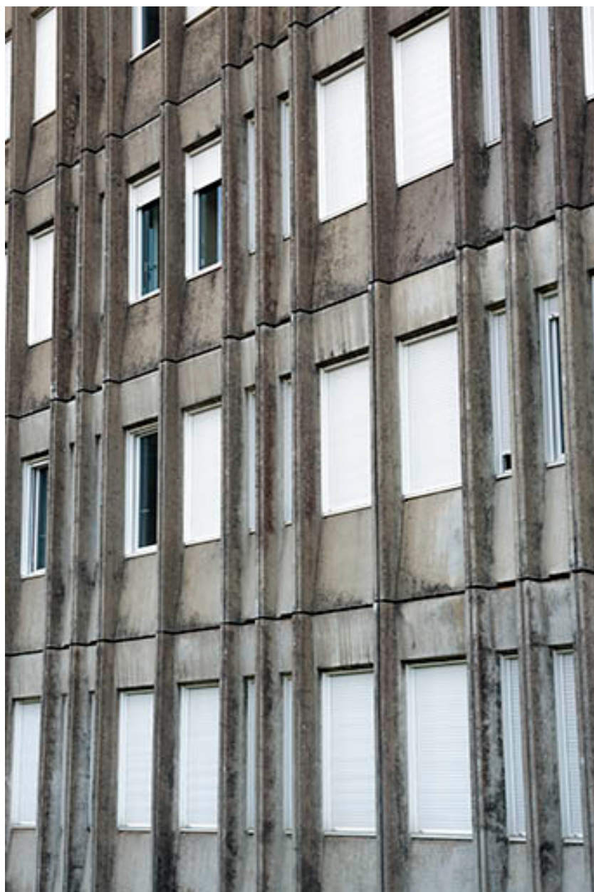
Détail de la façade de l'internat.
