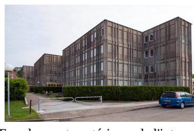
Façade ouest postérieure de l'internat.
