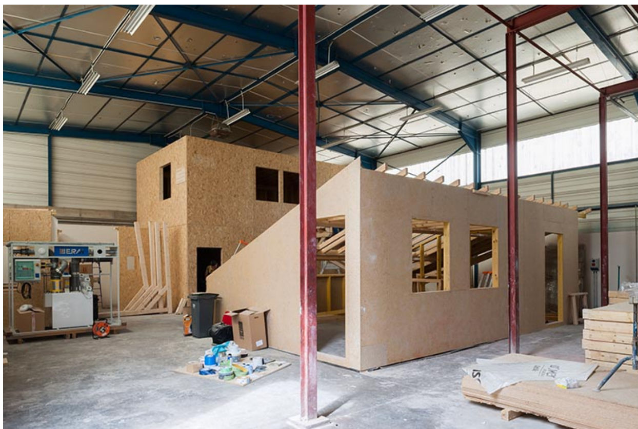
Espaces d'apprentissage des techniques de menuiserie.
