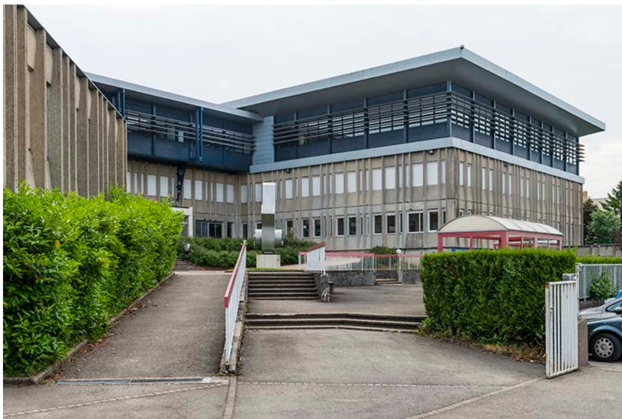
Vue d'ensemble : entrée, cour, externat surélevé, sculpture.
