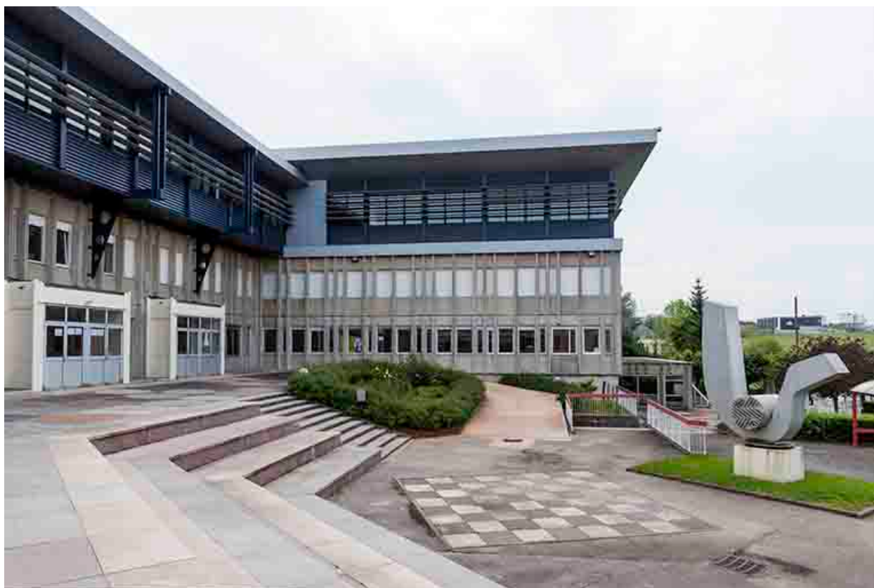
Vue d'ensemble : entrée, cour, externat surélevé, sculpture.
