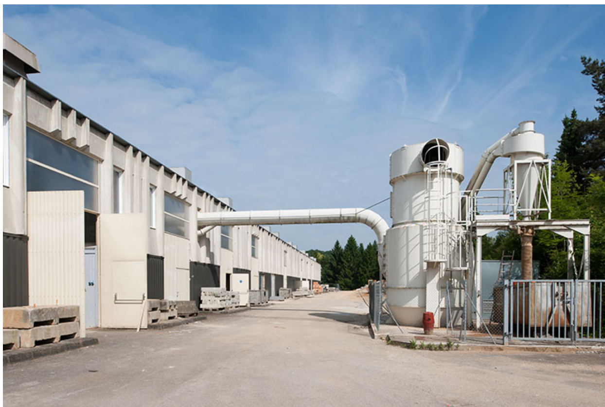
Façade postérieure nord-est de l'externat depuis l'est.
