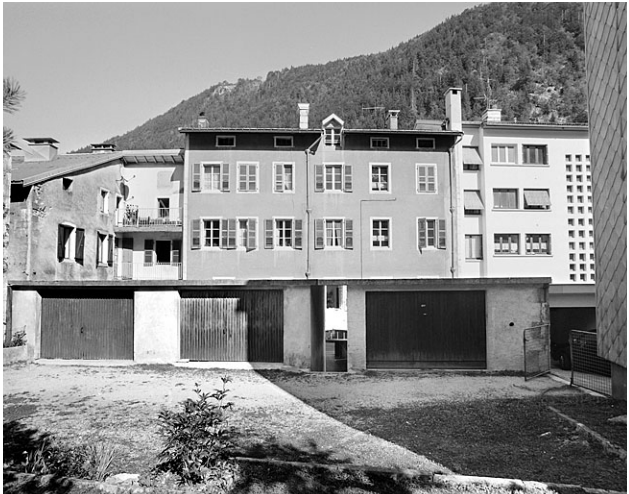
Elévation postérieure et garages.
