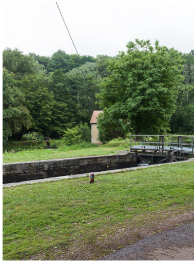
Vue du sas. Phot. Pierre-Marie Barbe-Richaud IVR26_20175800271NUC2A
