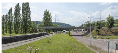
Vue d'ensemble. Phot. Pierre-Marie Barbe-Richaud IVR26_20122101941NUC4AQ
