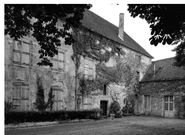
Bâtiment est. Façade prise du nord-est. Phot. Jean-Luc Duthu IVR26_19965800271V
