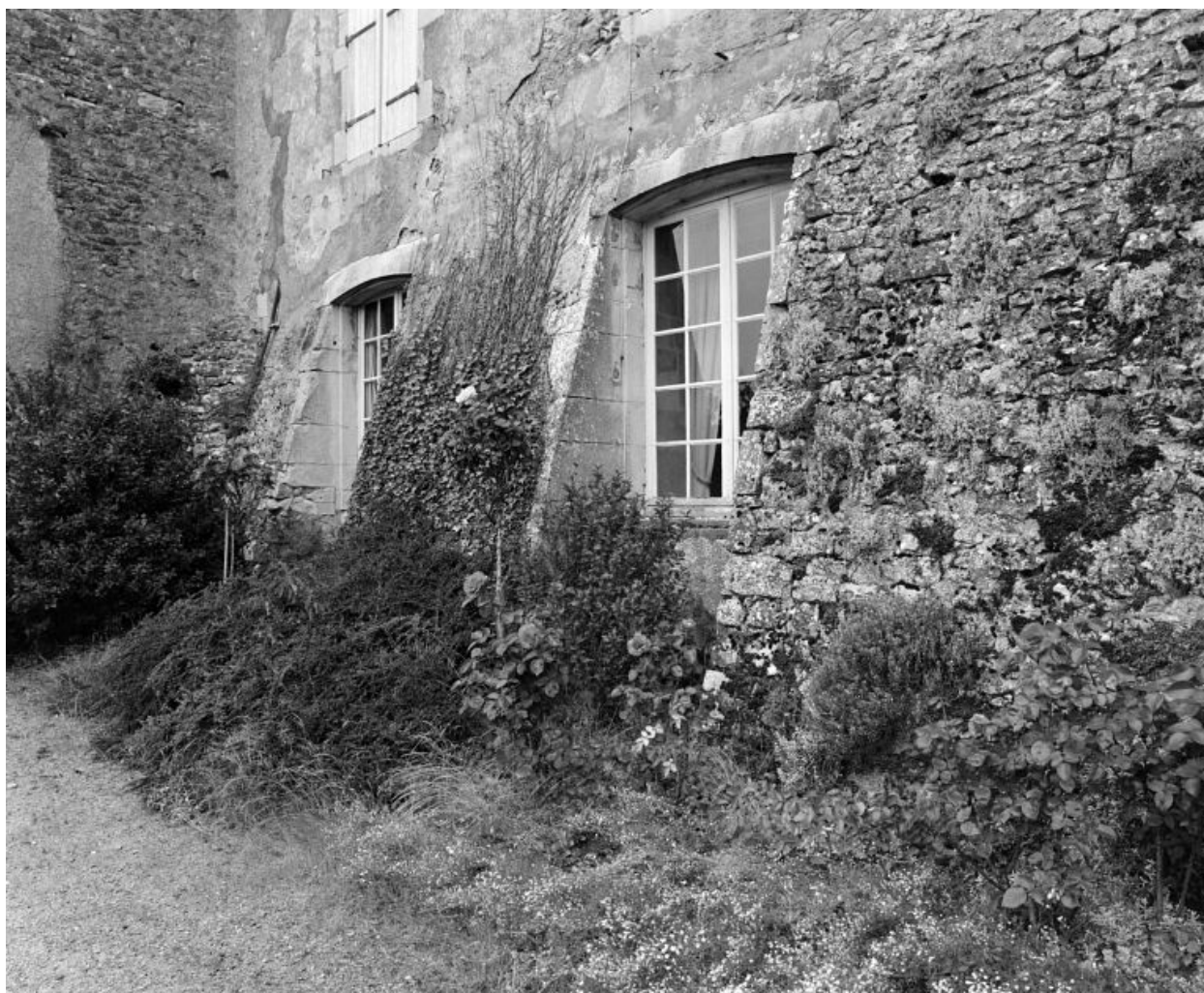
Bâtiment sud-ouest. Elévation antérieure, détail.
