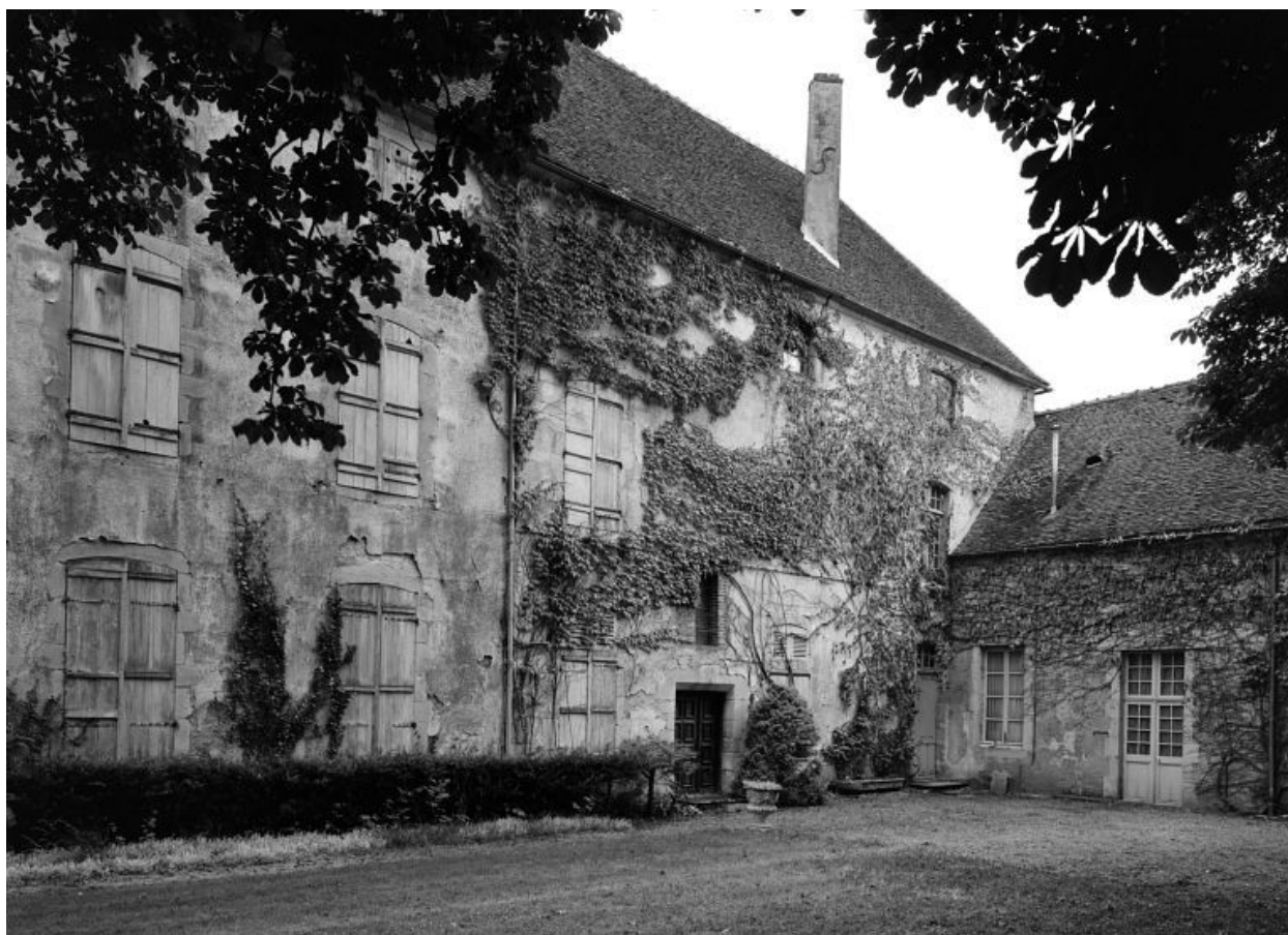
Bâtiment est. Façade prise du nord-est.
