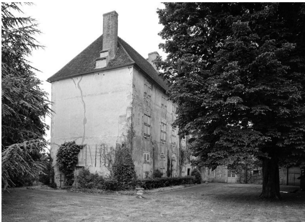
Bâtiment est. Vue d'ensemble.
