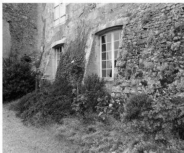
Bâtiment sud-ouest. Elévation antérieure, détail. Phot. Jean-Luc Duthu IVR26_19965800275X
