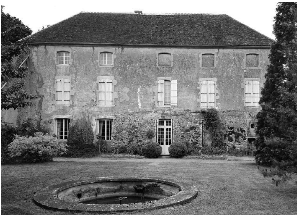
Bâtiment sud-ouest. Elévation antérieure.
