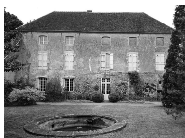
Bâtiment sud-ouest. Elévation antérieure. Phot. Jean-Luc Duthu IVR26_19965800274V
