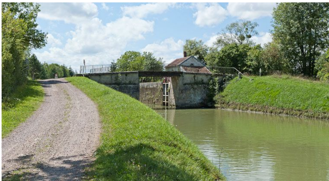
Vue du pont depuis l'aval.
