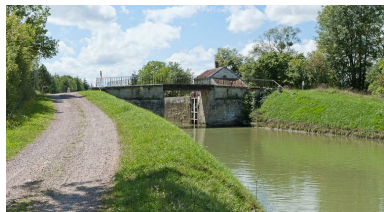
Vue du pont depuis l'aval. Phot. Pierre-Marie Barbe-Richaud IVR26_20112103796NUC4AQ
