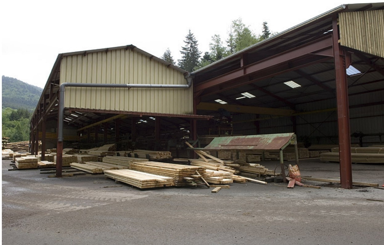
Atelier de fabrication de la nouvelle scierie.
