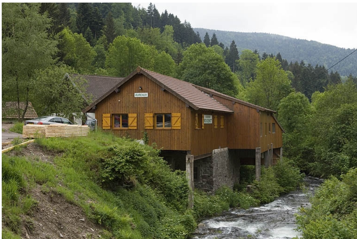
Bâtiment (réhabilité) de la scierie primitive.
