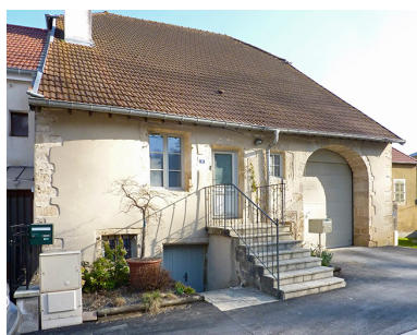
Ferme-bloc, 6 place de l'Abondance. Phot. Liliane Hamelin IVR43_20177001181NUC2A
