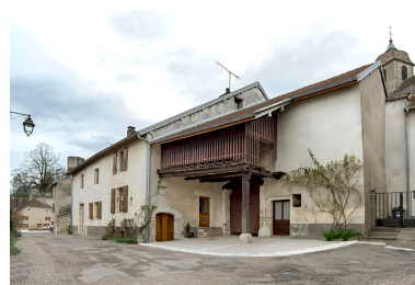
Ferme-bloc, 1 ruelle du Moulin. Les logis à gauche et la grange à droite sont couverts par deux toits différents ; notez la présence du "perché", avancée en bois en surplomb au-dessus de la porte de grange. Phot. Sonia Dourlot IVR43_20167000900NUC4A
