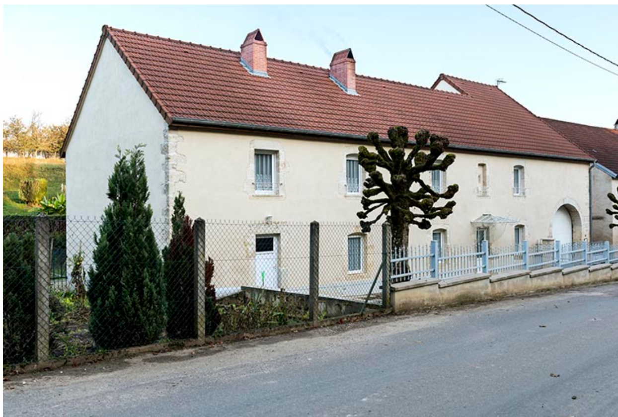
Ferme-bloc, 10-14 rue de la Garenne.
