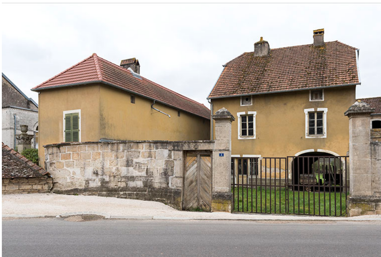
Ferme (?) avec boutique, 3 rue du Pâquis.
