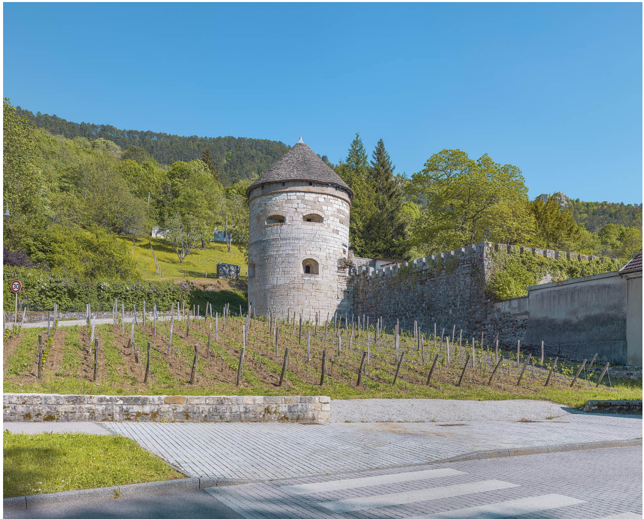
Vue depuis l'ouest.
