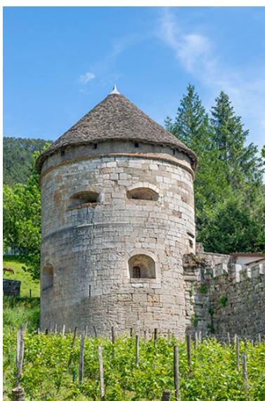
Vue rapprochée. Phot. Jérôme Mongreville IVR43_20243900689NUC4A
