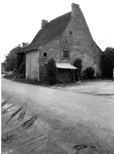
Façade latérale droite.
