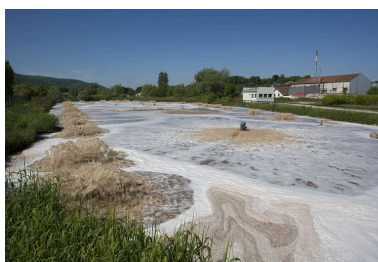
Bassin de décantation et atelier de trituration. Vue depuis le sud-est.
