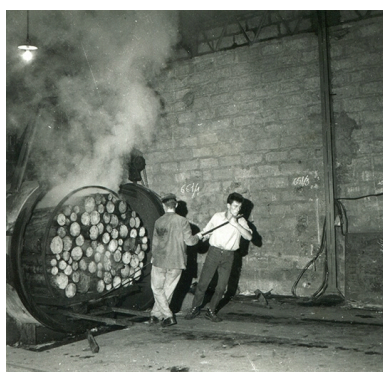
Etuvage du bois. Sortie d'un chariot, fotogr., s.d. [3e quart 20e siècle]. IVR43_20152501942NUC4A
