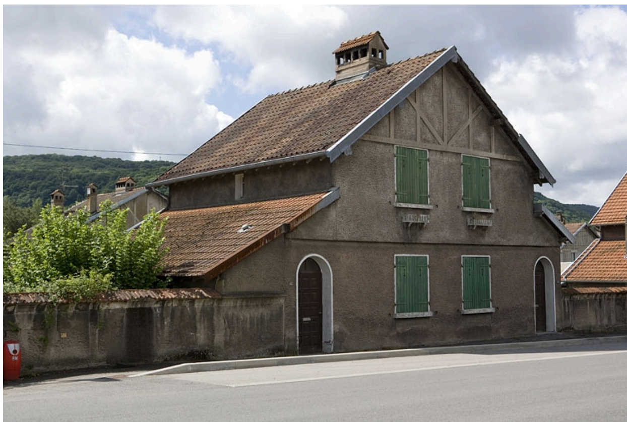
Cité Lehmann. Façade antérieure d'une maison.
