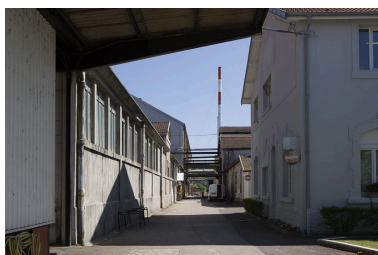
Passage entre l'atelier de la machine à papier et les ateliers de réparation et de maintenance.
