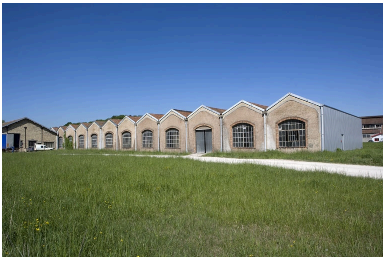
Magasin industriel. Façade sud.
