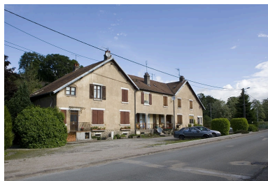
Logement d'ouvriers (13, 15, 17 rue Weibel). Façade antérieure de trois quarts droite. Phot. Yves Sancey IVR43_20092500571NUC2A
