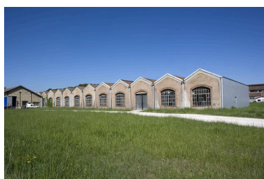
Magasin industriel. Façade sud.
