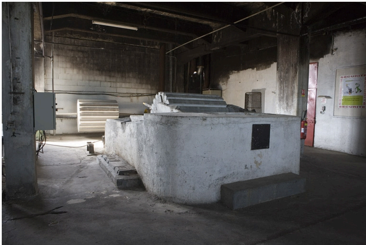
Pile raffineuse. Vue arrière.
