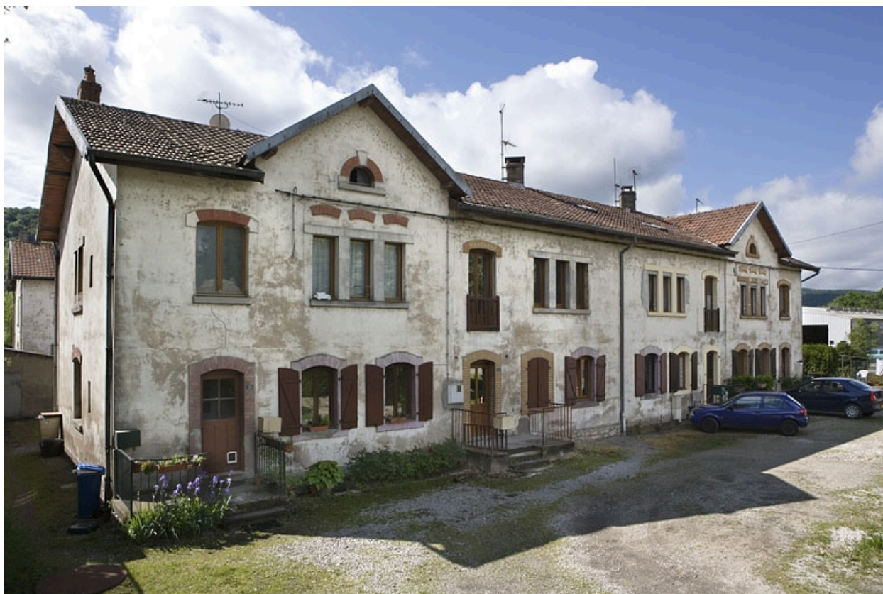
Cité ouvrière (rue Weibel). Façade antérieure du logement collectif situé 19 au 25 rue Weibel.
