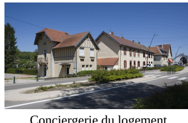
Conciergerie du logement patronal, cité la Cude et magasin coopératif. Vue de trois quarts. Phot. Yves Sancey IVR43_20092500568NUC2A
