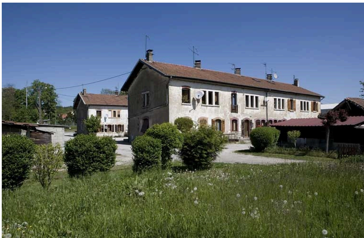
Cité ouvrière (rue Weibel). Logement collectif depuis le sud-ouest.
