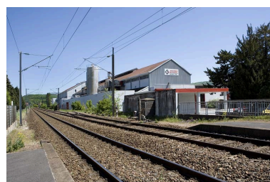
La papeterie depuis la voie ferrée. Phot. Yves Sancey IVR43_20092500523NUC2A
