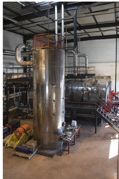
Chaudière. Vue intérieure.
