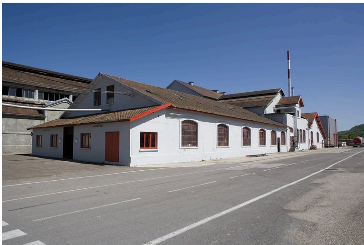
Vue d'ensemble des façades sud des ateliers de réparation et de maintenance.
