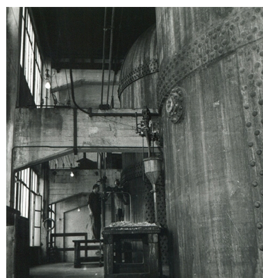
Chaudières (?), fotogr., s.d. [3e quart 20e siècle]. IVR43_20152501955NUC4A
