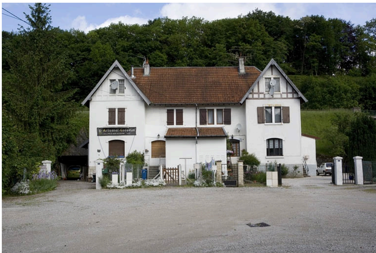
Logement d'ouvriers (3, 5 rue Weibel). Façade antérieure.
