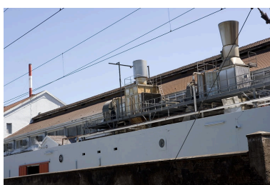
Atelier de la machine à papier. Extracteurs d'air.
