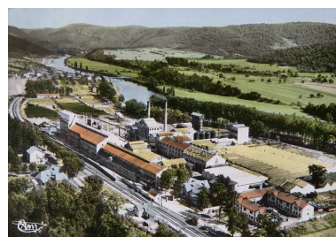
Vue aérienne, depuis le nord-ouest. Phot. Yves Sancey IVR43_20092500585NUC2A
