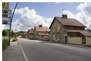
Cité ouvrière Lehmann vue de trois quarts droite. Phot. Yves Sancey IVR43_20092500584NUC2A
