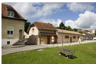
Salle des loisirs et de cinéma. Vue de trois quarts droite. Phot. Yves Sancey IVR43_20092500566NUC2A
