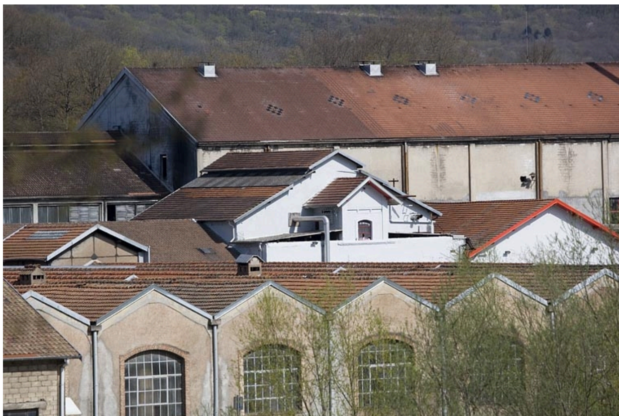
Vue rapprochée des couvertures depuis le sud.
