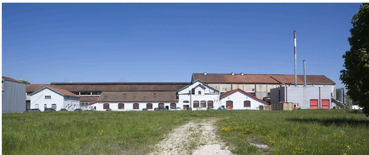
Façades sur cour des bâtiments industriels depuis le sud.
