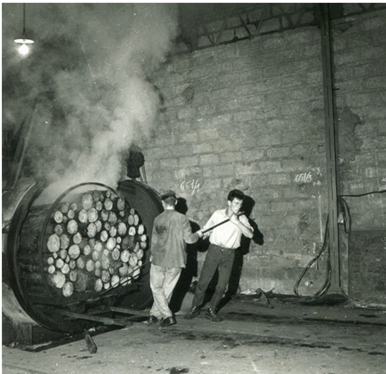
Etuvage du bois. Sortie d'un chariot, fotogr., s.d. [3e quart 20e siècle].
