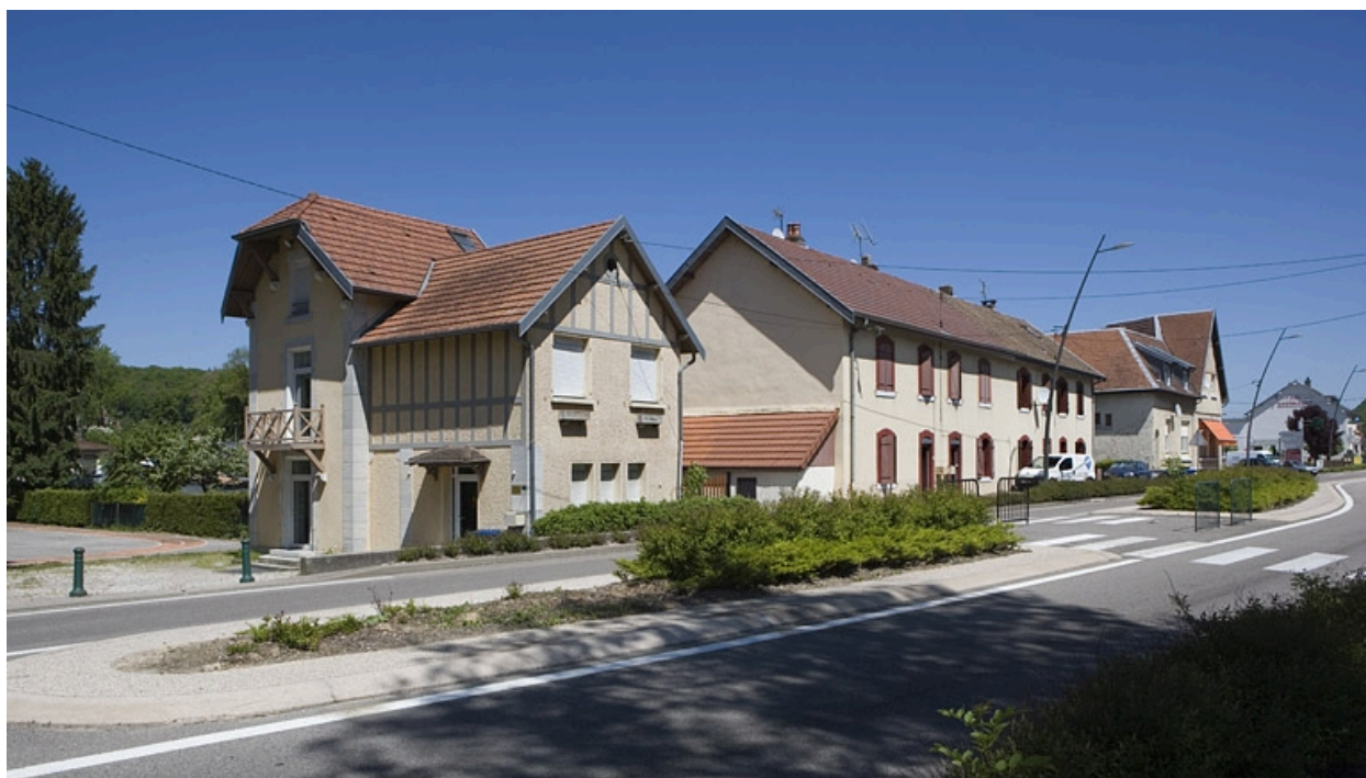
Conciergerie du logement patronal, cité la Cude et magasin coopératif. Vue de trois quarts.
