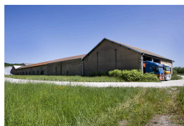
Magasin industriel. Pignon ouest.
