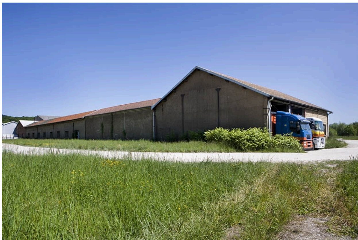
Magasin industriel. Pignon ouest.
