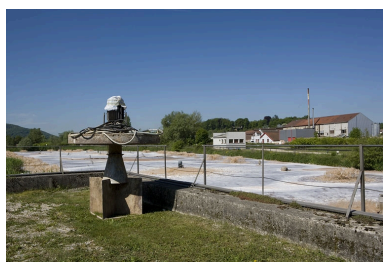
Vue de l'atelier de trituration depuis un bassin de décantation.
