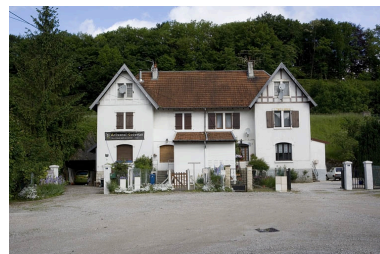
Logement d'ouvriers (3, 5 rue Weibel). Façade antérieure.
