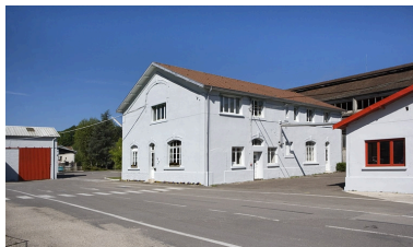
Bureaux. Vue de trois quarts droite.
