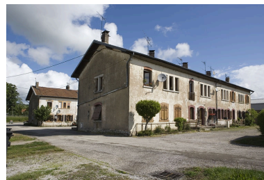
Cité ouvrière (rue Weibel). Vue rapprochée d'une façade postérieure. Phot. Yves Sancey IVR43_20092500575NUC2A
