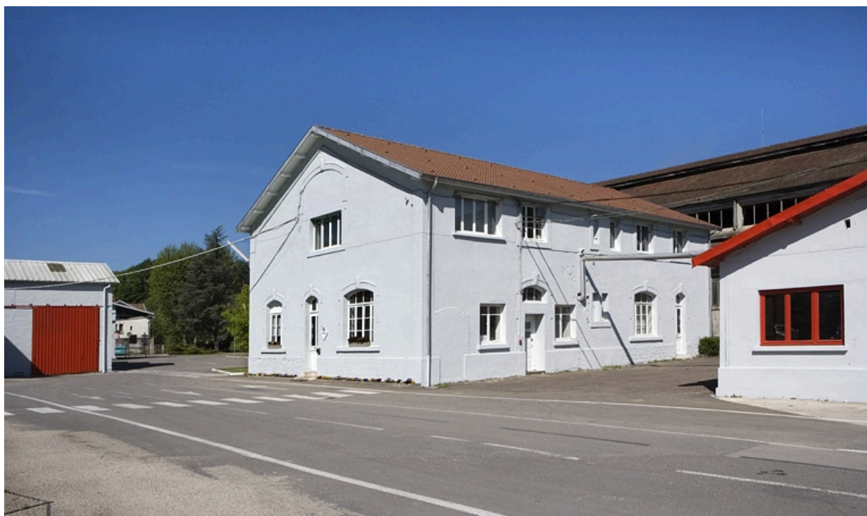
Bureaux. Vue de trois quarts droite.
