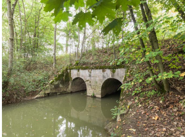
Vue de l'aqueduc. Phot. Pierre-Marie Barbe-Richaud IVR26_20177100470NUC2A
