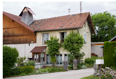
Façade antérieure de l'atelier. Phot. Sonia Dourlot IVR43_20142500905NUC2A
