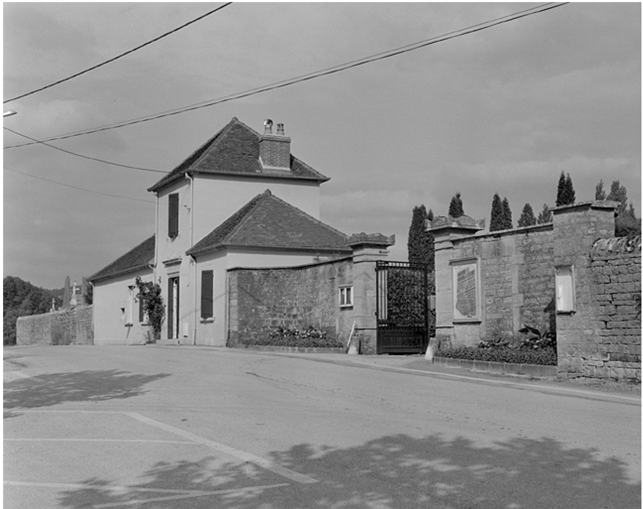
Portail d'entrée et maison du gardien.
