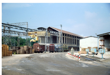
Pont-bascule (40), pont roulant (17) et hangar à terre (18). Phot. Laurent Poupard IVR43_19893901025ZA
