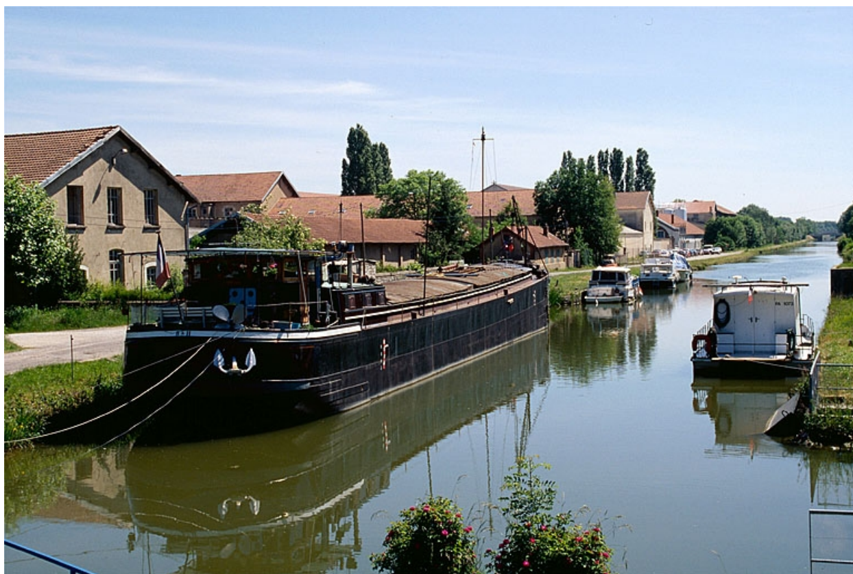
Vue d'ensemble de l'usine, depuis l'écluse.
