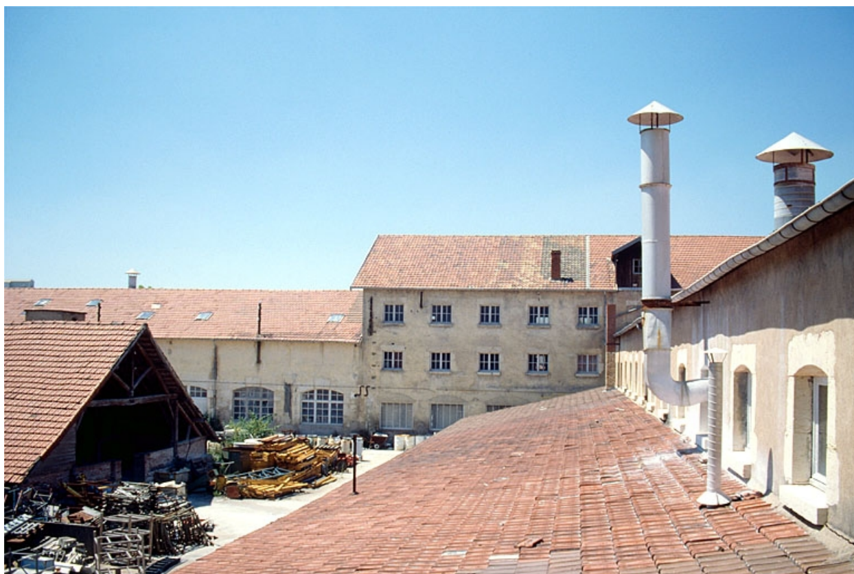
Vue partielle de l'atelier (27), depuis l'est.
