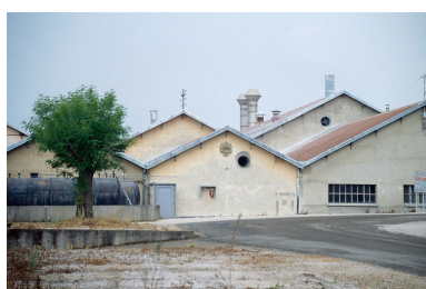
Pignon oriental des ateliers (38) et mascaron. Phot. Laurent Poupard IVR43_19893901022ZA
