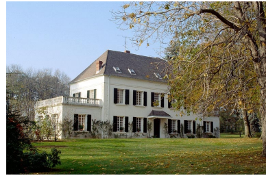
Logement patronal (10), vu de trois quarts gauche. Phot. Laurent Poupard IVR43_19893901049ZA
