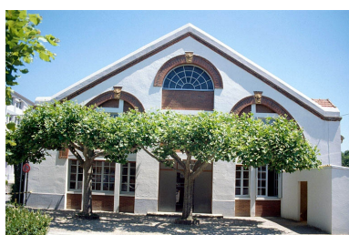
Façade antérieure des bureaux, vue de face. Phot. Laurent Poupard IVR43_19893901006ZA
