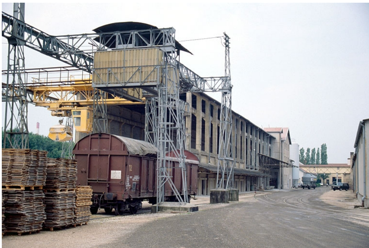
Pont roulant et hangar à terre (18).
