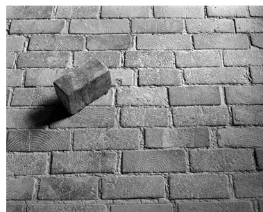
Hangar à terre (25) : détail du pavé en bois. Phot. Yves Sancey IVR43_19893901018X
