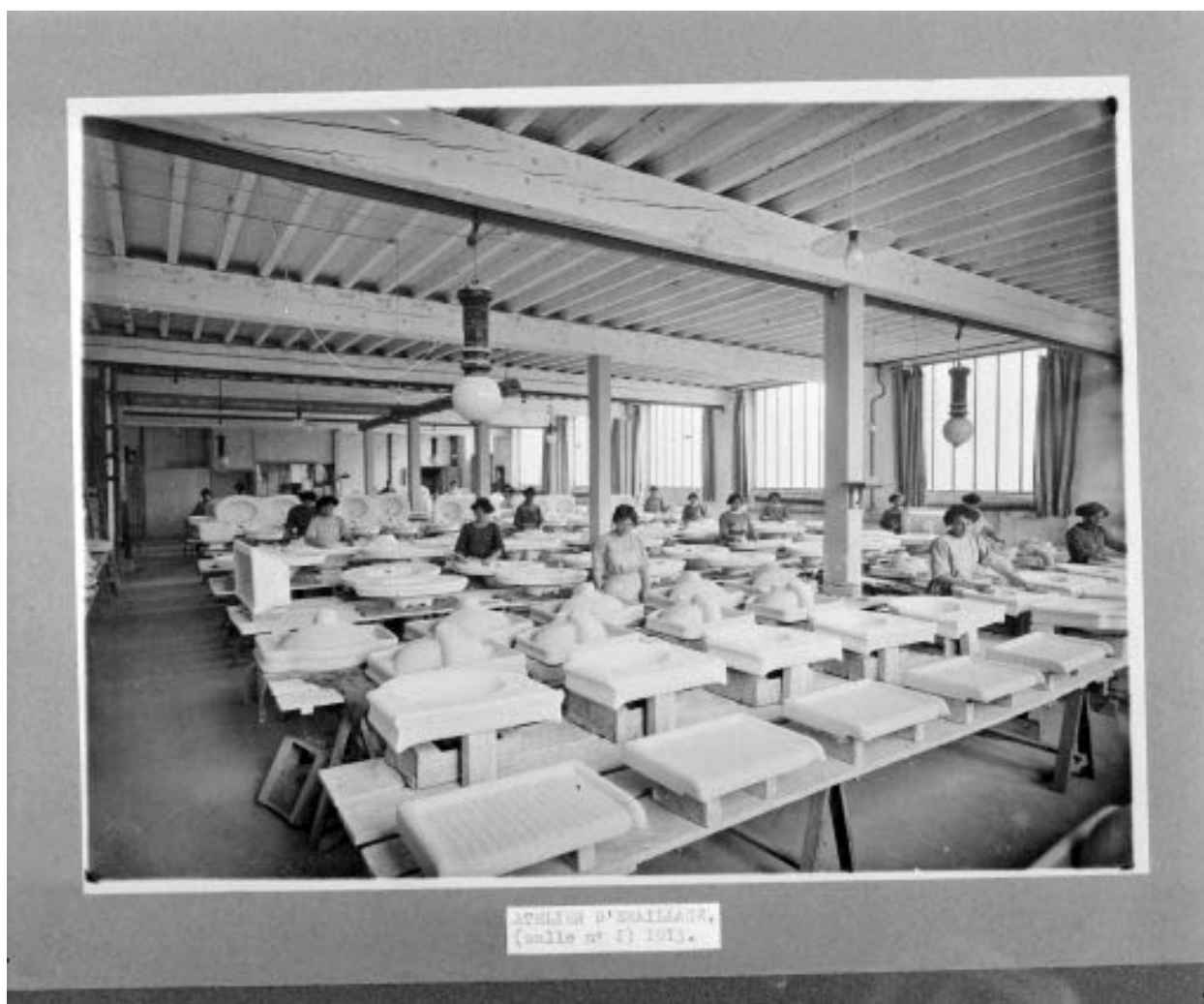
L'atelier d'émaillage, salle n° 1 (bâtiment 46).
