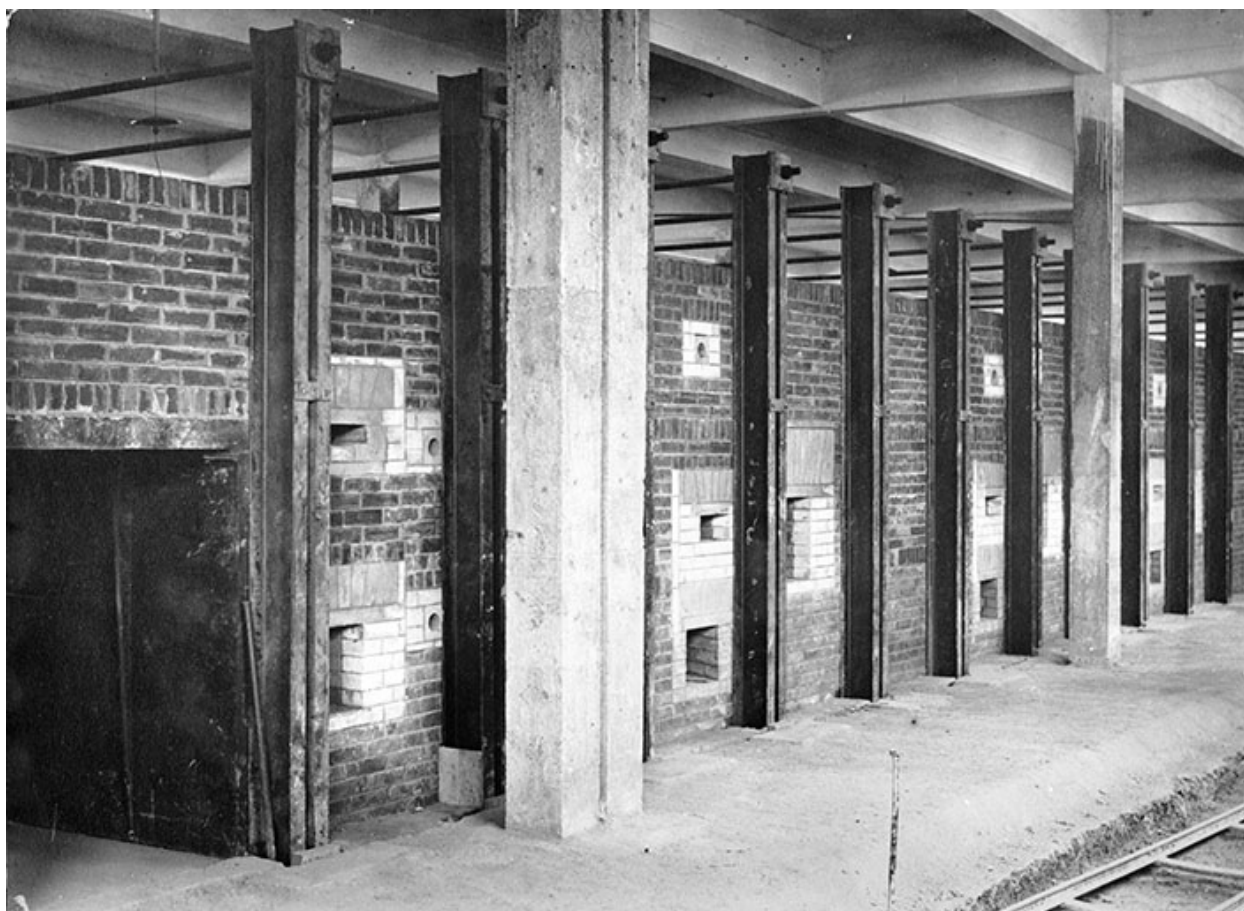
Four Dressler en construction : vue latérale.
