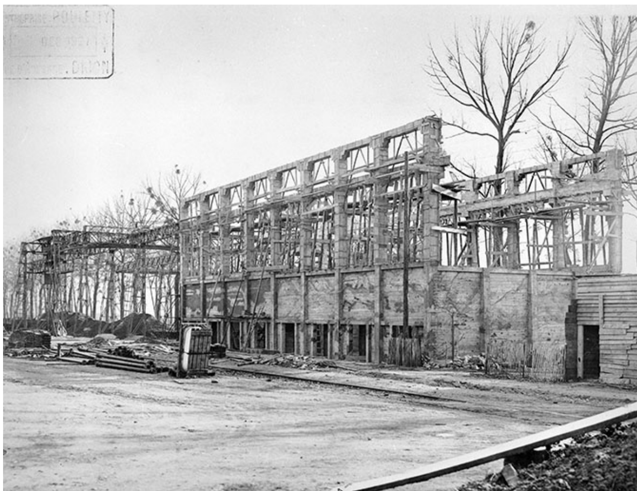
Hangar à terre (18) en construction.
