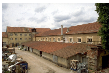
Vue partielle de l'atelier (27), depuis l'est. Phot. Yves Sancey IVR43_19973901797ZA
