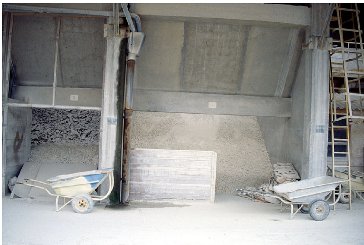
Hangar à terre (18) : détail des silos ouverts.
