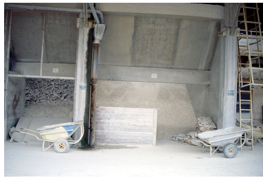
Hangar à terre (18) : détail des silos ouverts.
