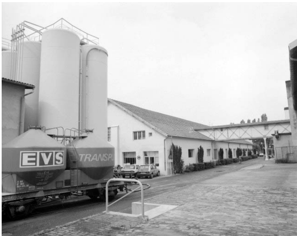
Façades postérieure et latérale gauche des bureaux.
