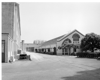
Bureaux (20), vue de trois quarts gauche. Phot. Yves Sancey IVR43_19893901003X
