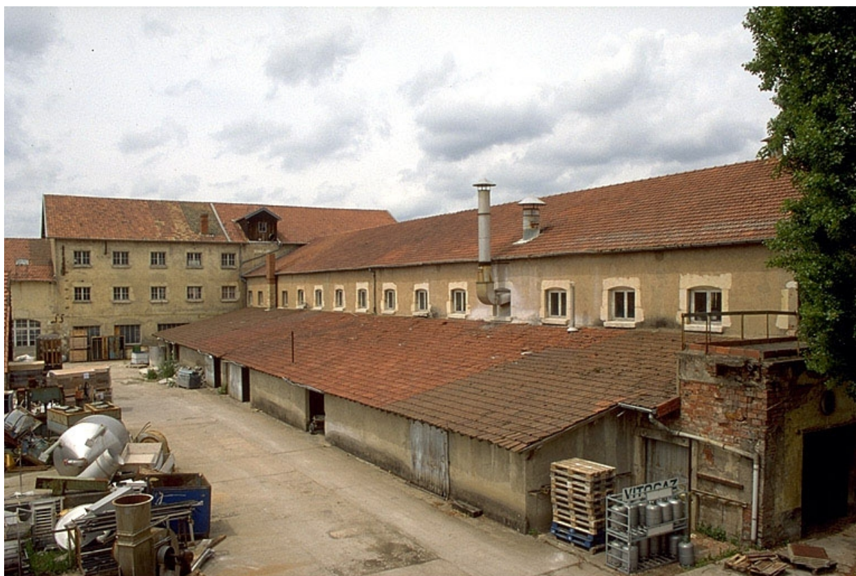
Vue partielle de l'atelier (27), depuis l'est.
