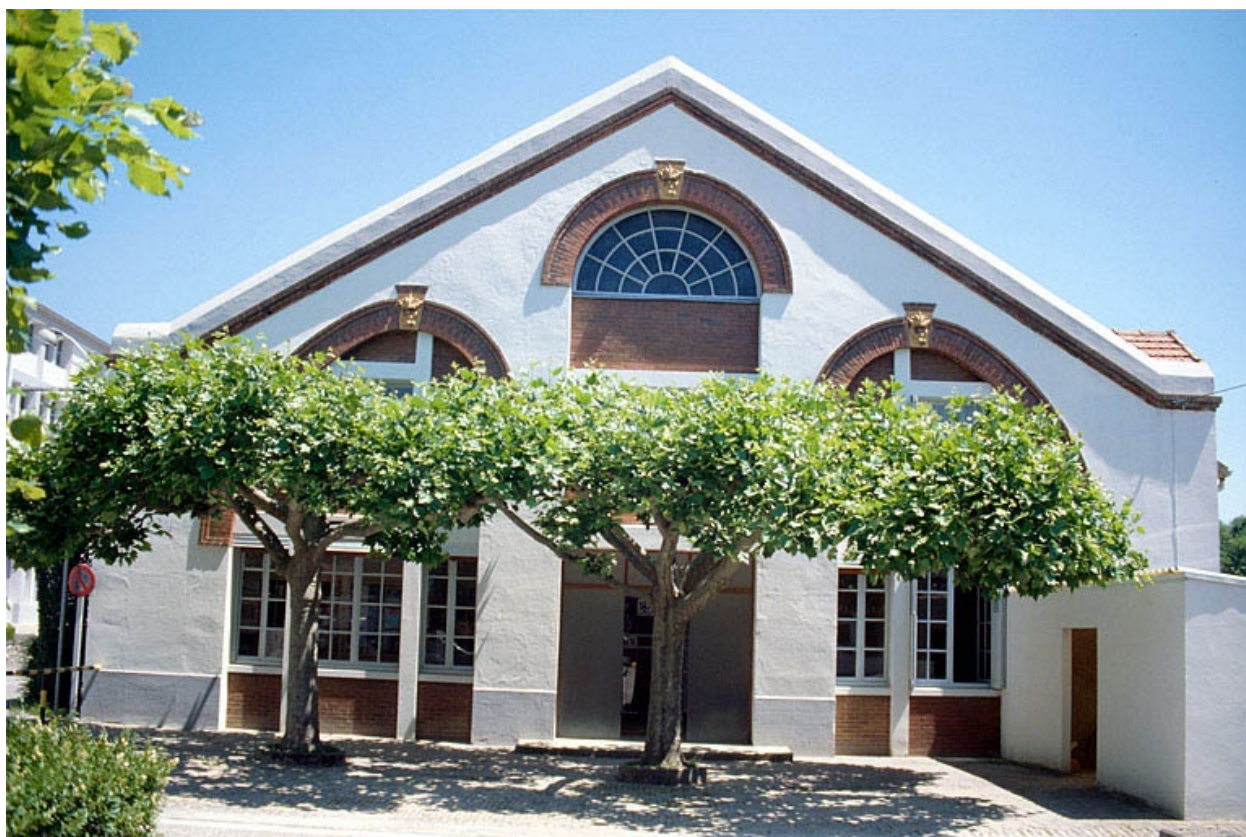
Façade antérieure des bureaux, vue de face.
