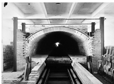
Four Dressler en construction : vue de face. Phot. Yves Sancey IVR43_19893900655X
