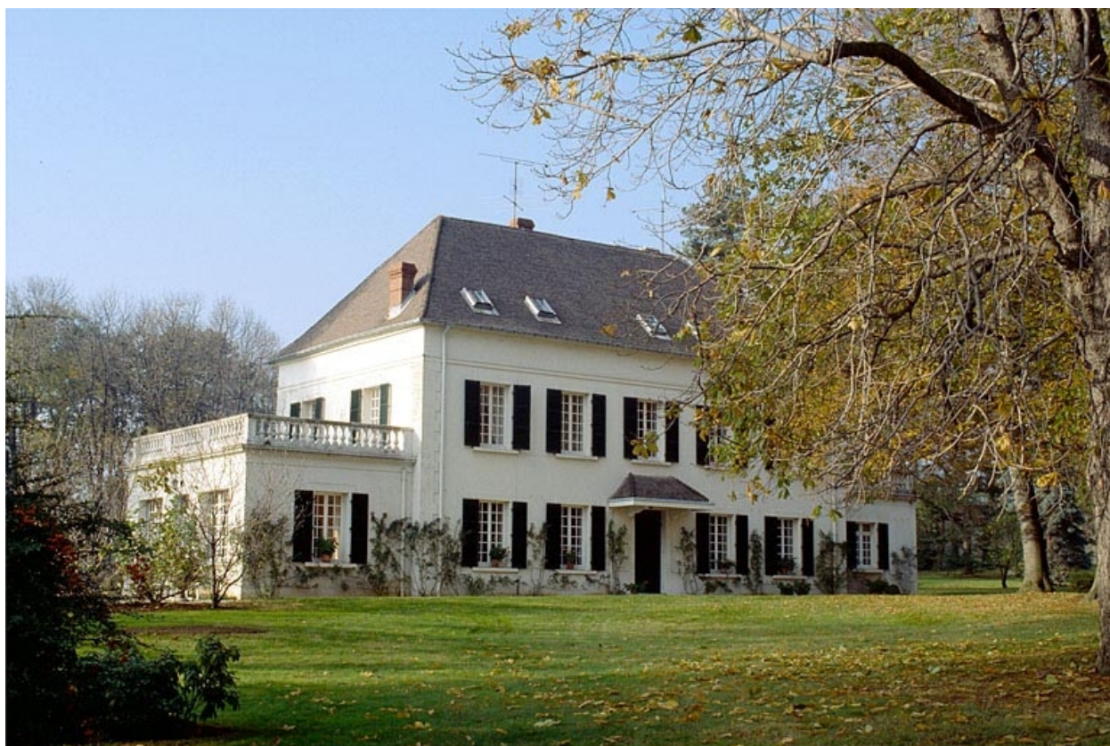
Logement patronal (10), vu de trois quarts gauche.
