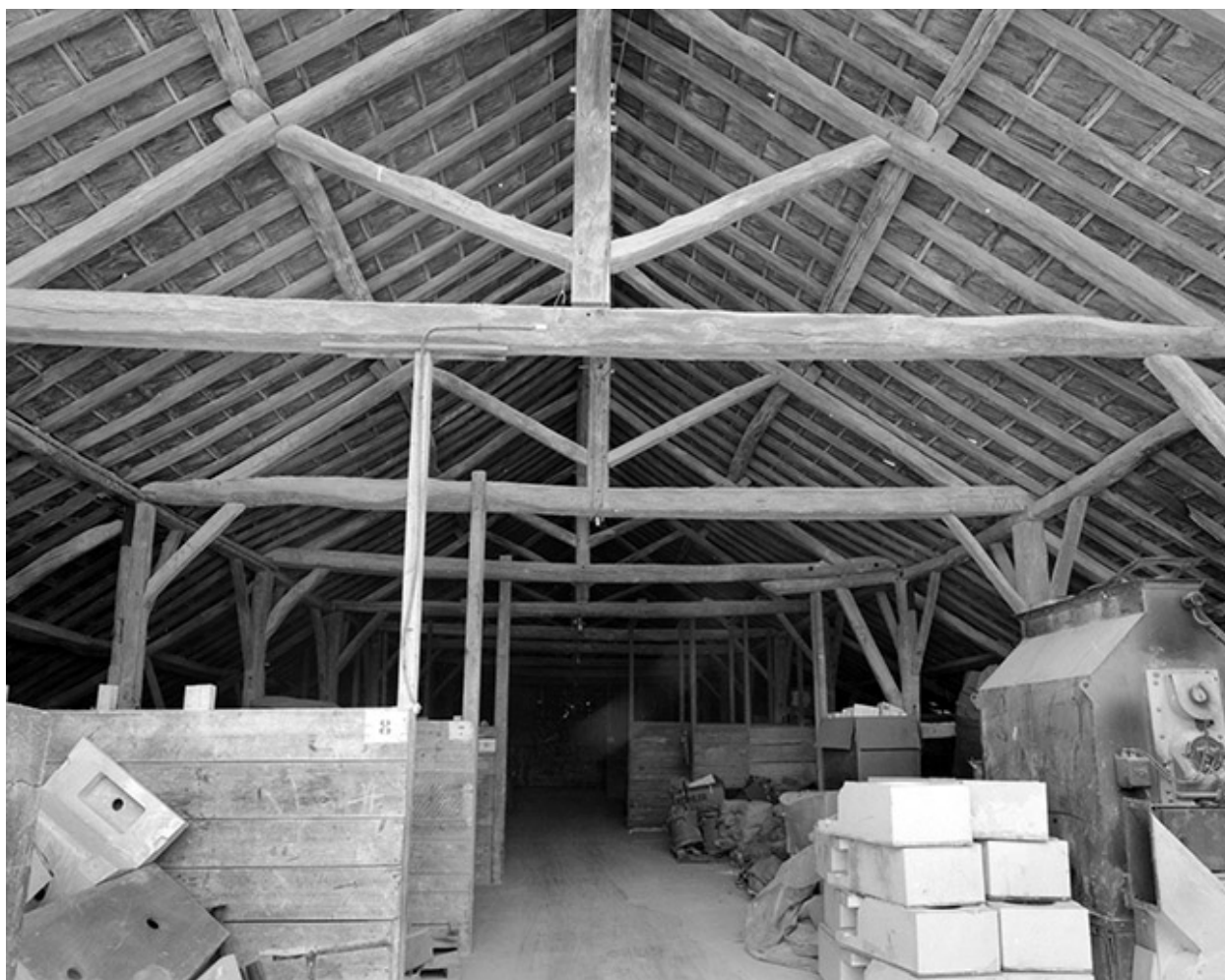
Charpente du hangar à terre (25).
