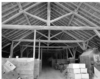
Charpente du hangar à terre (25). Phot. Yves Sancey IVR43_19893901016X
