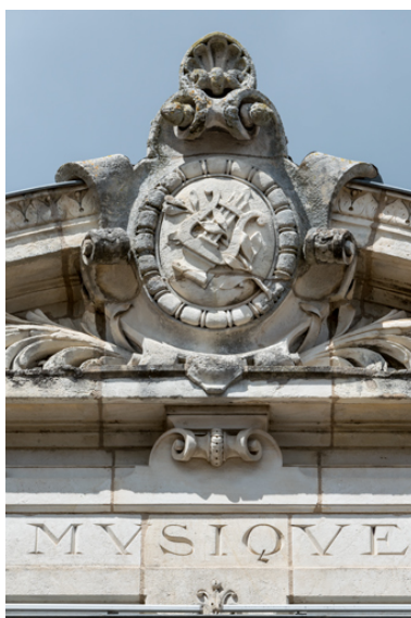
Travée gauche : décor du fronton. Phot. Pierre-Marie Barbe-Richaud IVR26_20235800256NUC4A
