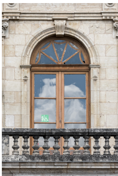
Travée droite : baie de l'étage carré. Phot. Pierre-Marie Barbe-Richaud IVR26_20235800253NUC4A
