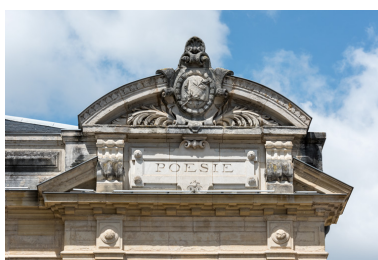
Travée droite : inscription et frontons. Phot. Pierre-Marie Barbe-Richaud IVR26_20235800254NUC4A
