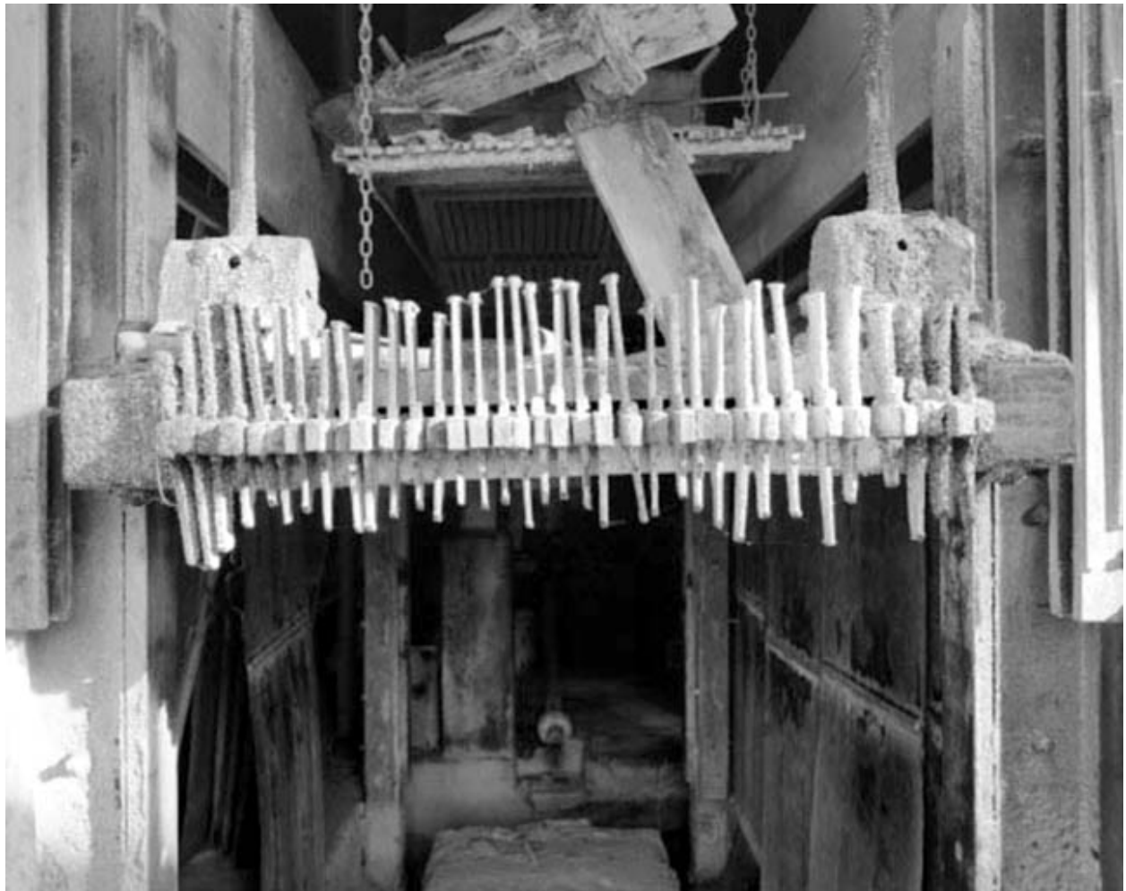
Blocage de l'extrémité des lames.
