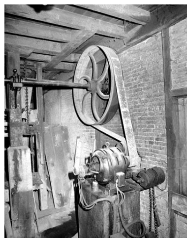
Système d'entraînement : moteur électrique.
