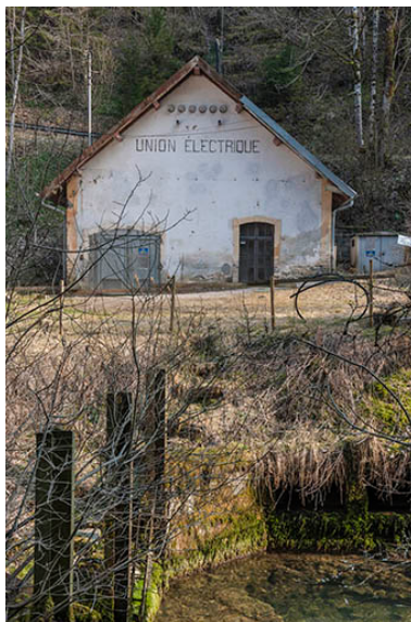
Façade antérieure de la centrale. Phot. Jérôme Mongreville IVR43_20152500331NUC4A
