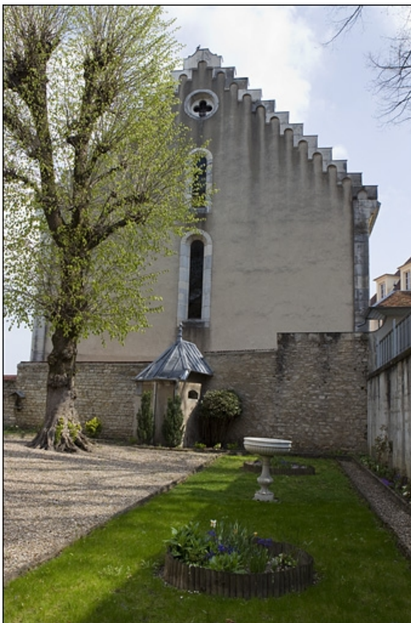
Vue éloignée du pavillon de jardin.
