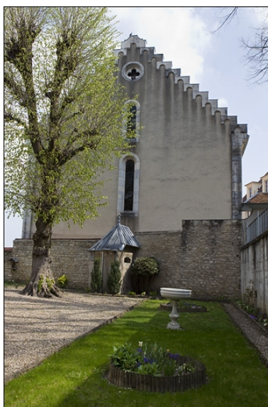
Vue éloignée du pavillon de jardin. Phot. Yves Sancey IVR43_20102500422NUC2A
