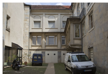
Vue d'ensemble de la cour postérieure.
