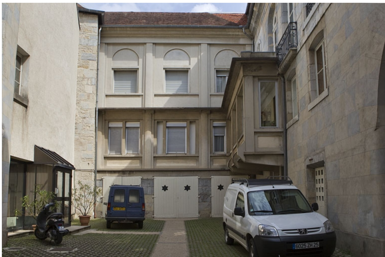
Vue d'ensemble de la cour postérieure.
