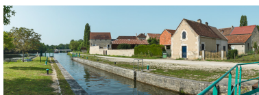
Vue du site. Phot. Pierre-Marie Barbe-Richaud IVR26_20178900151NUC2AQ
