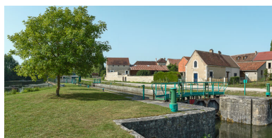
Vue du site d'écluse. Phot. Pierre-Marie Barbe-Richaud IVR26_20178900150NUC2AQ
