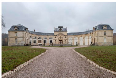
Écuries du château. Phot. Jérôme Mongreville IVR43_20187000768NUC4A
