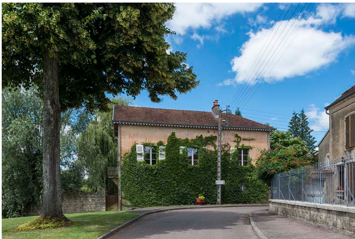
Ancienne tannerie, grande rue du Bourg.
