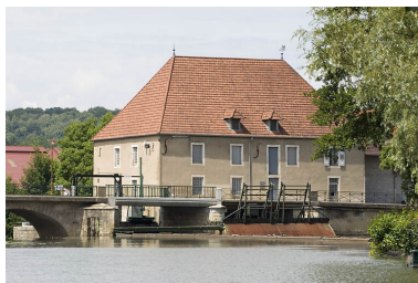
Centrale hydroélectrique. Phot. Jérôme Mongreville IVR43_20087000884NUC2A
