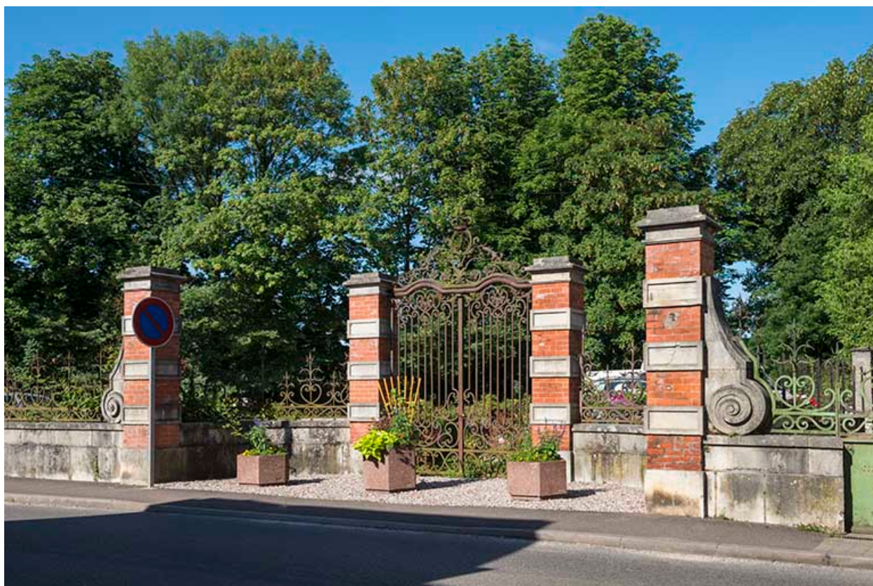
Clôture (grille) sur la rue Armand Paulmard.
