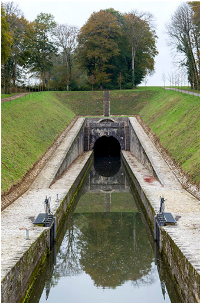
Entrée amont du tunnel de Saint-Albin.
