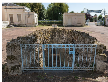
Escalier de la source, détail. Phot. Pierre-Marie Barbe-Richaud IVR26_20205800551NUC4A
