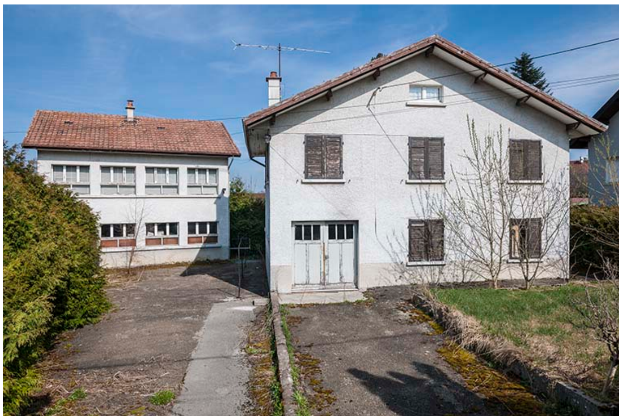
Atelier de fabrication et logement patronal.
