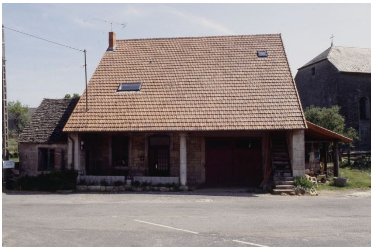
Façade antérieure vue de face.
