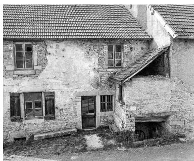
Maison cadastrée 1956 G1 182 Phot. Yves Sancey IVR43_19777000420X
