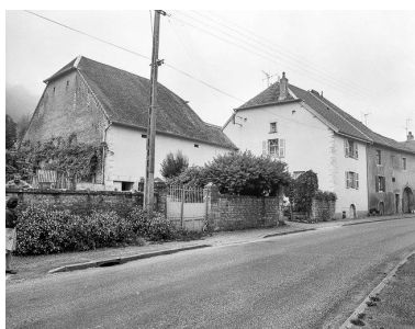
Ferme cadastrée 1956 G1 395 Phot. Dominique Dominguez IVR43_19807000327X
