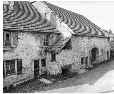
Maison cadastrée 1956 G1 182 Phot. Yves Sancey IVR43_19777000419X
