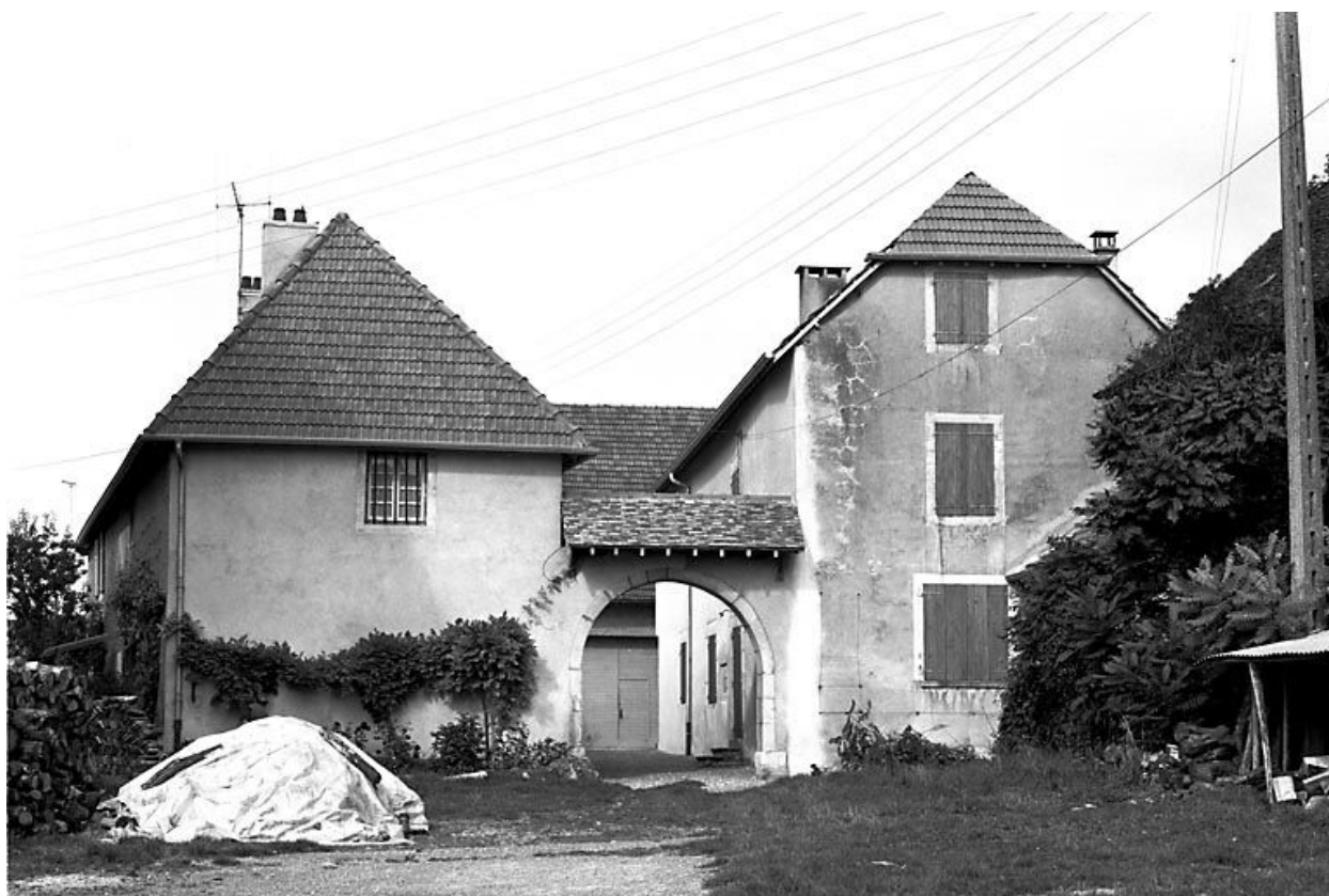
Ferme située place de l'Eglise.
