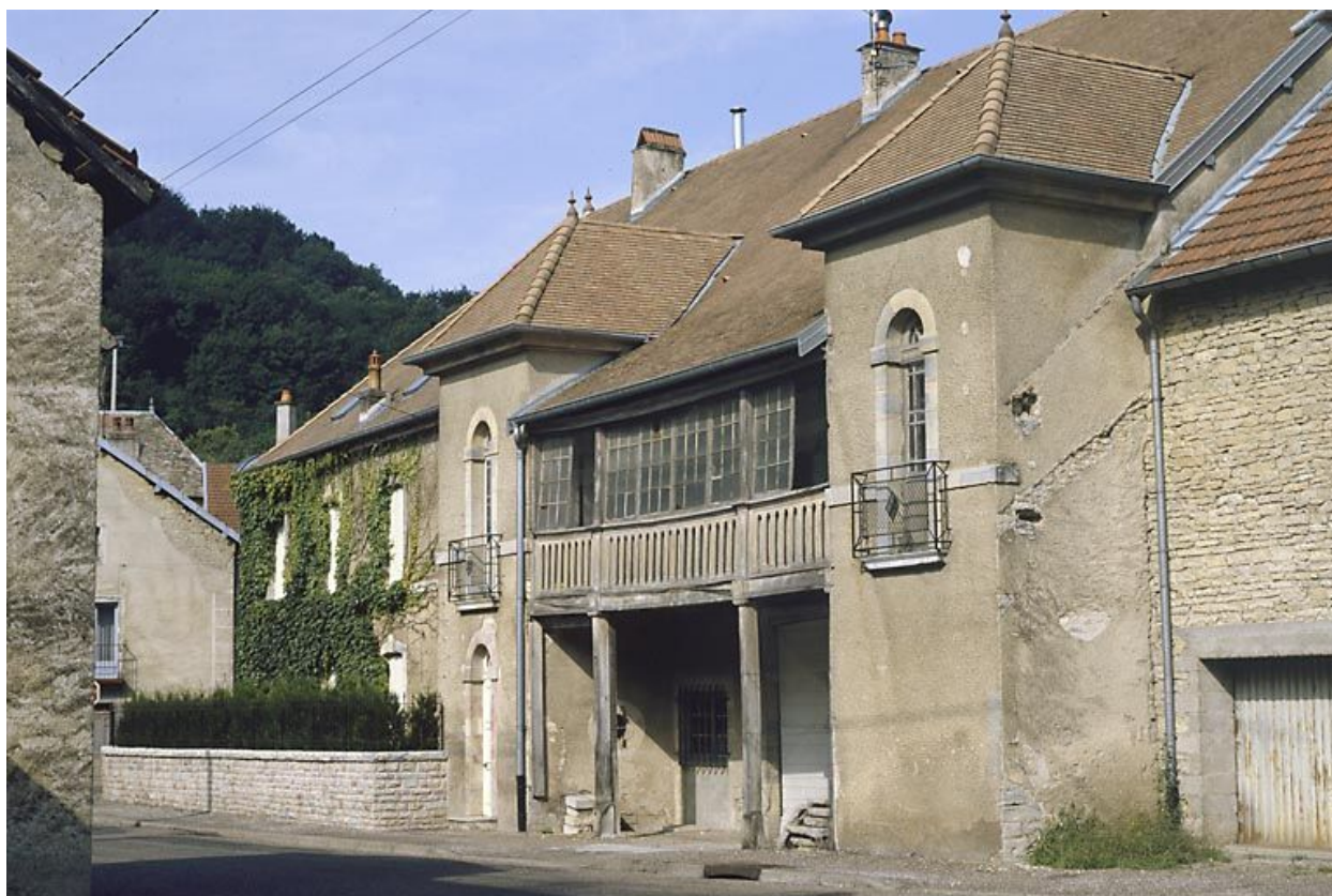
Maison située 33 Grande Rue.
