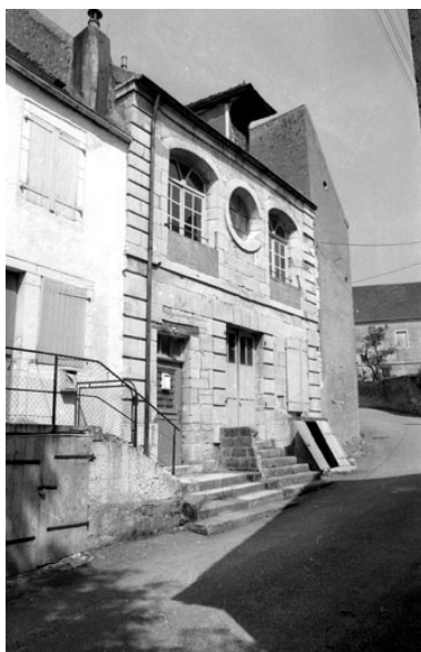
Vue de trois quarts gauche. Phot. Bernard Lardière IVR43_19817000749Z
