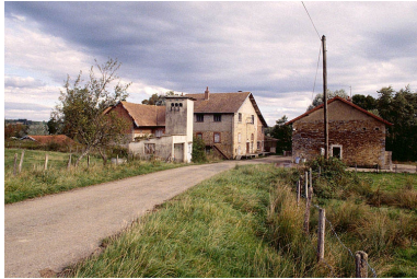
Vue d'ensemble. Phot. Jérôme Mongreville IVR43_19953900404ZA
