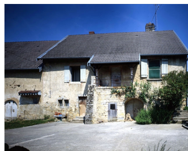
Façade antérieure. Phot. Yves Sancey IVR43_19903901167VA
