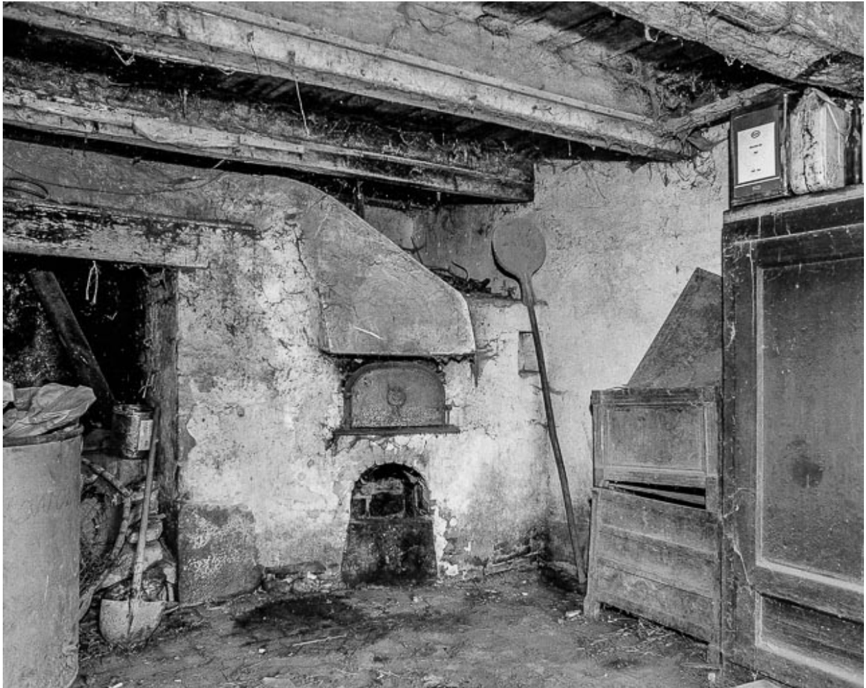
Le four au rez-de-chaussée de l'habitation.
