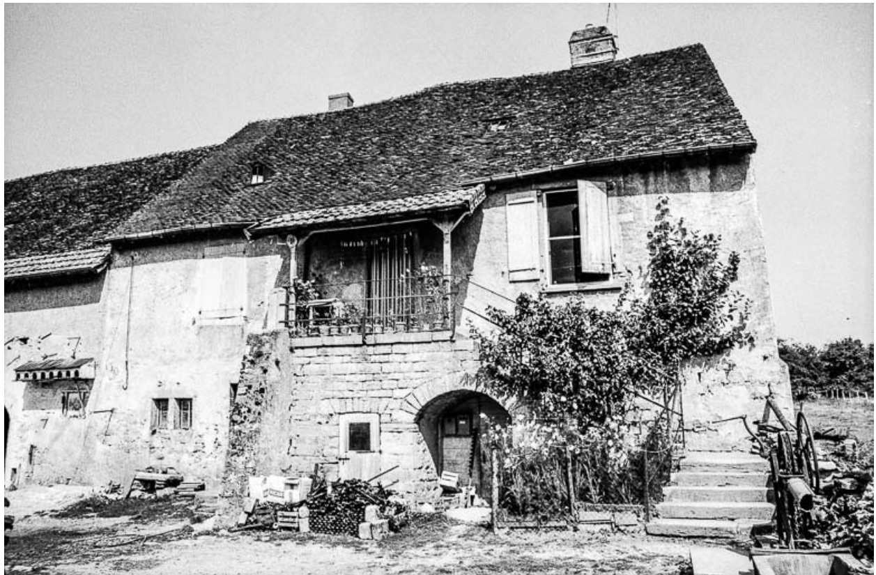
Façade antérieure : vue rapprochée.
