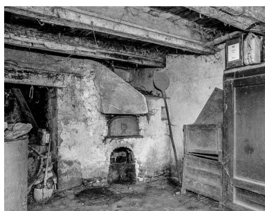
Le four au rez-de- chaussée de l'habitation.
