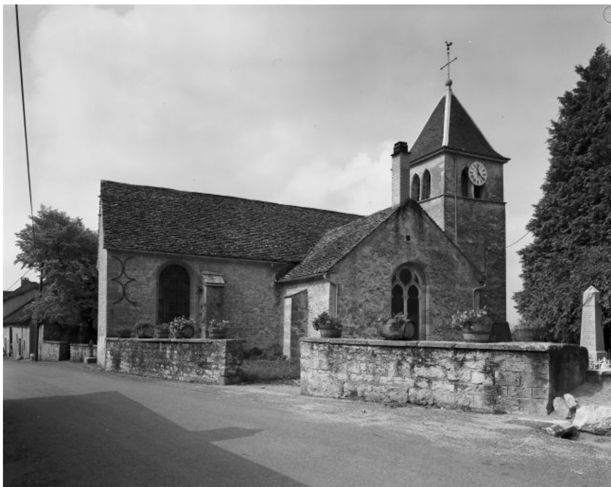
Vue d'ensemble extérieure.
