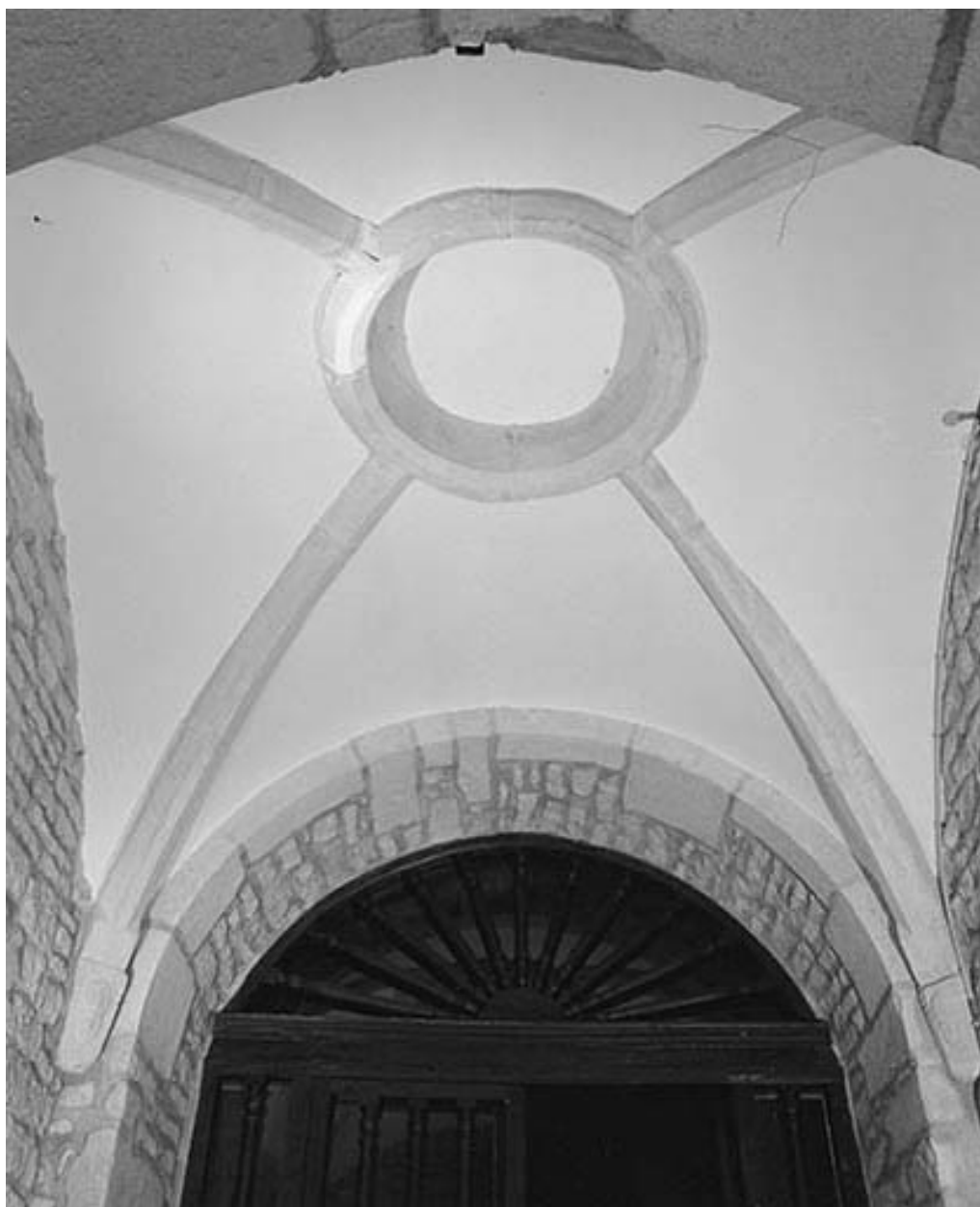
Intérieur : voûte du vestibule.
