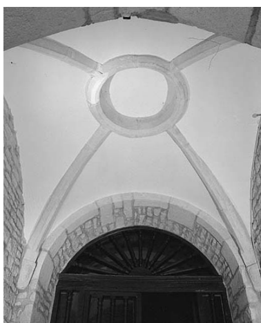
Intérieur : voûte du vestibule.
