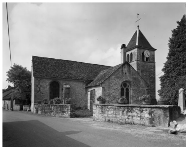
Vue d'ensemble extérieure.
