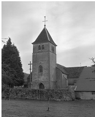
Extérieur : façade antérieure.
