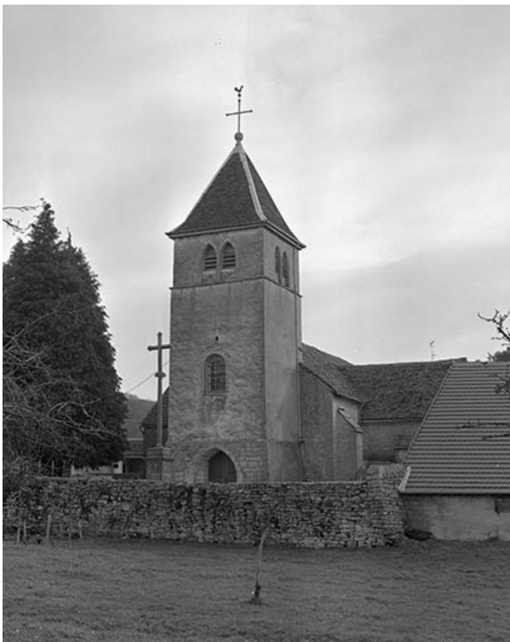
Extérieur : façade antérieure.
