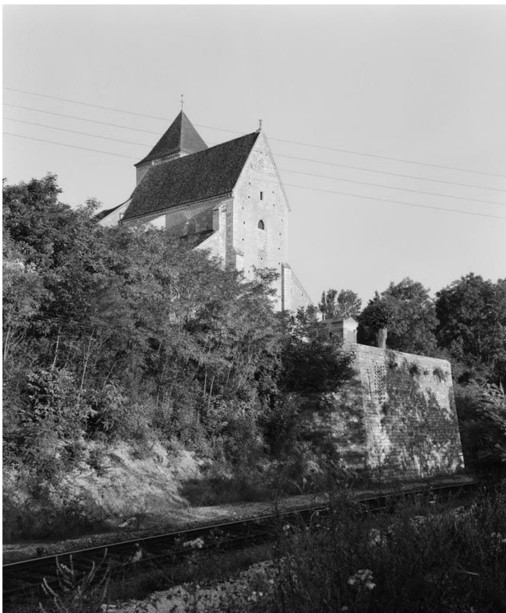
Vue d'ensemble, prise du canal.
