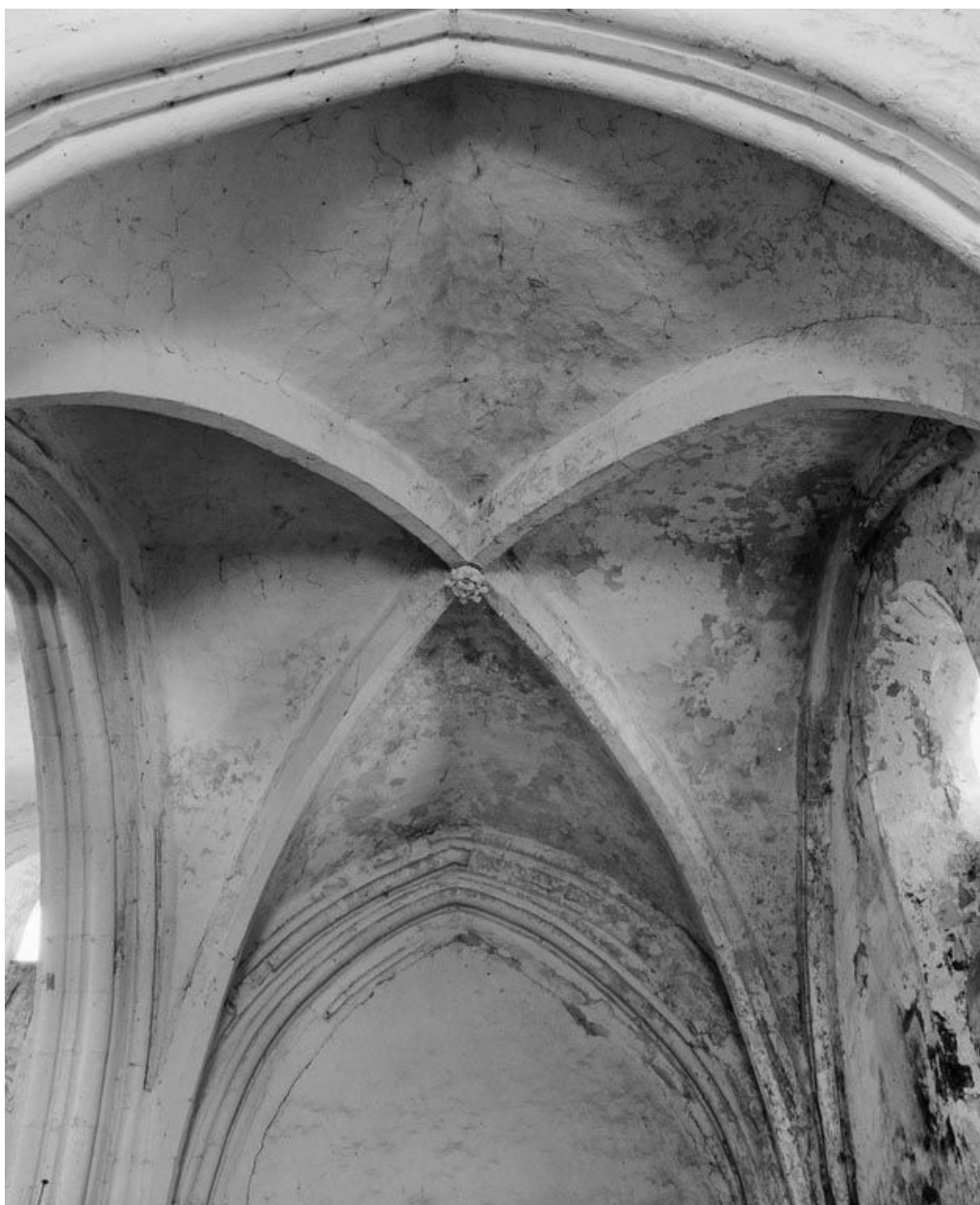
Collatéral gauche, 2è travée : voûtement.
