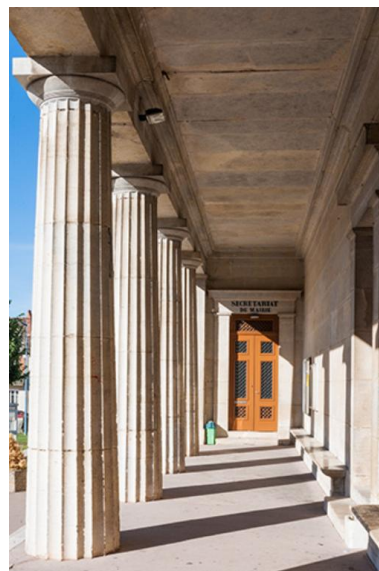
Le porche de l'hôtel de ville Phot. Jérôme Mongreville IVR43_20137000266NUCA
