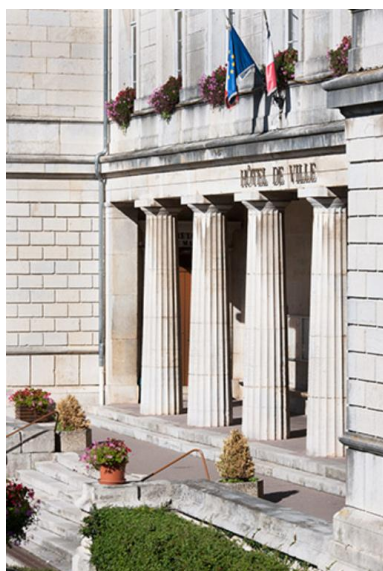
Porche de la façade sud Phot. Jérôme Mongreville IVR43_20137000274NUCA
