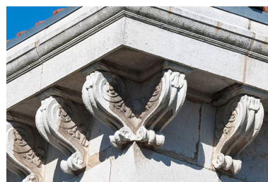
Détail de la corniche Phot. Jérôme Mongreville IVR43_20137000273NUCA
