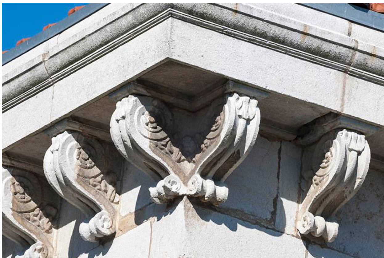
Détail de la corniche
