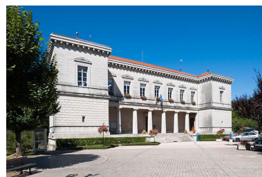
Vue générale sud-ouest Phot. Jérôme Mongreville IVR43_20137000278NUCA
