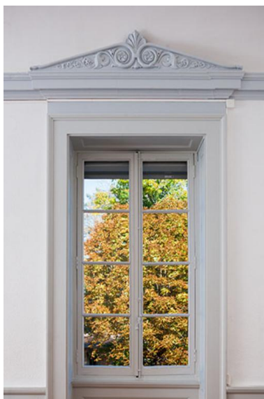
Détail de l'une des baies Phot. Jérôme Mongreville IVR43_20137000447NUCA
