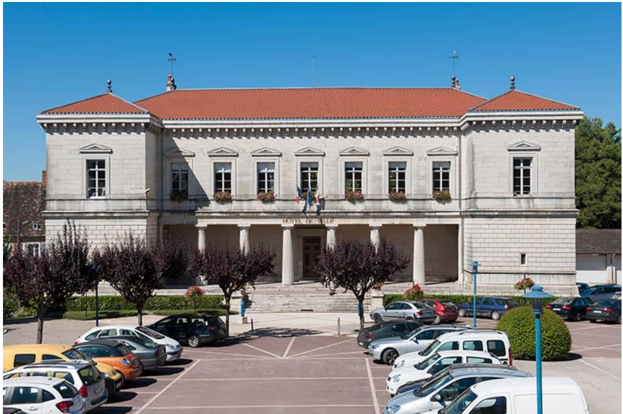
Vue générale sud
