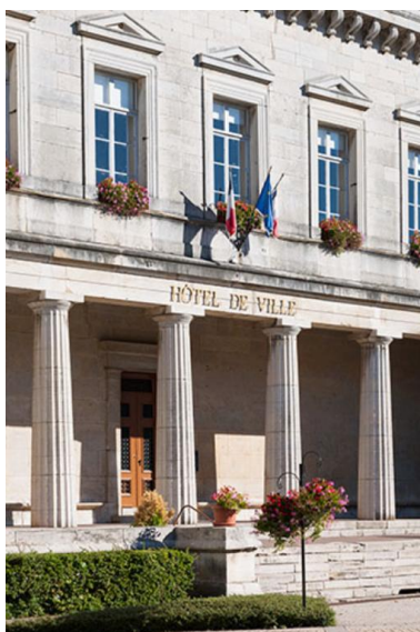
Vue sud-ouest du porche Phot. Jérôme Mongreville IVR43_20137000268NUCA
