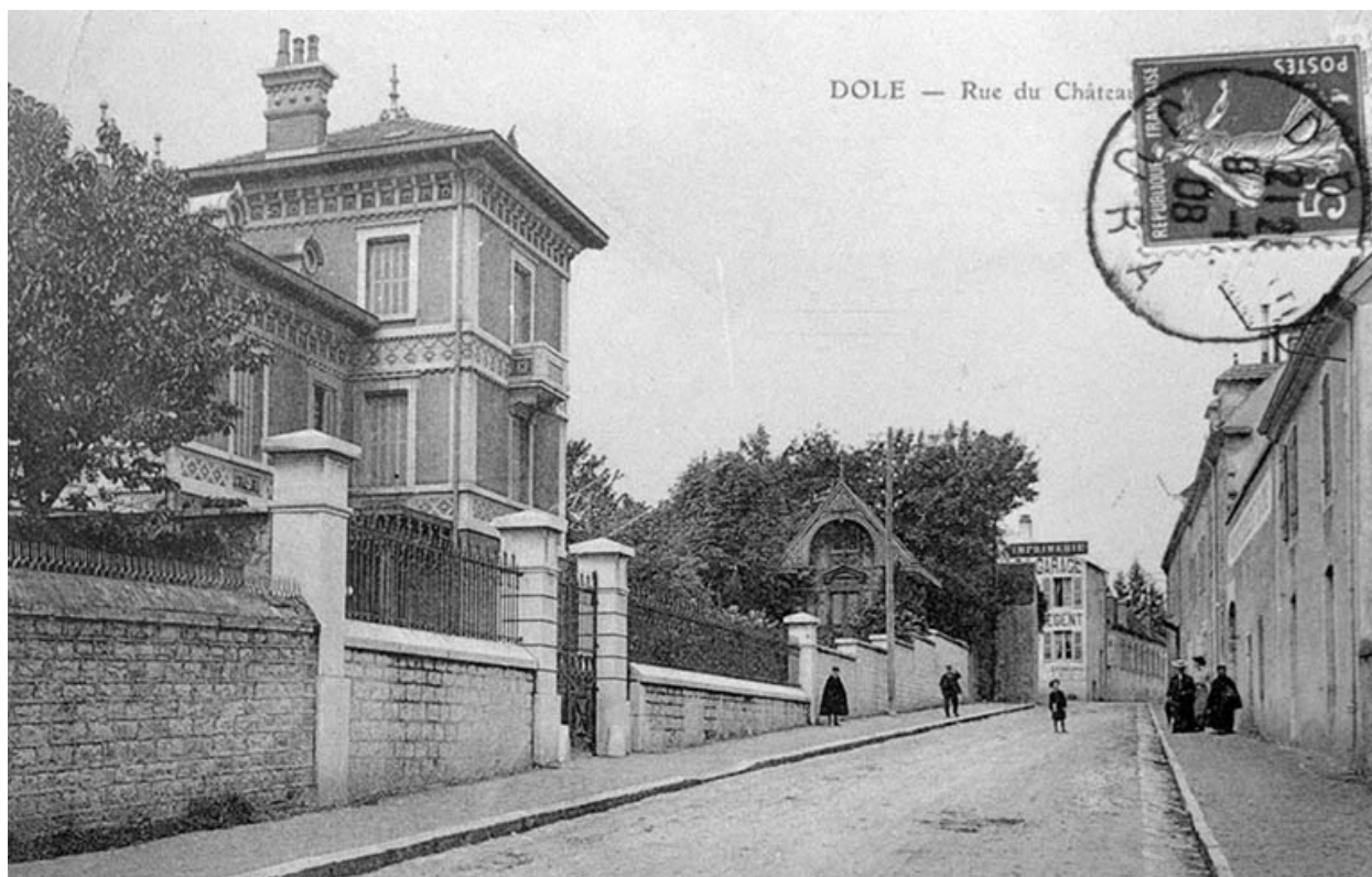
Dole - Rue du Château d'eau.
