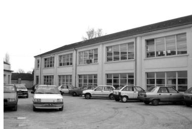
Bureau, bureau d'études et laboratoire. Phot. Laurent Poupard IVR43_19893900125Z
