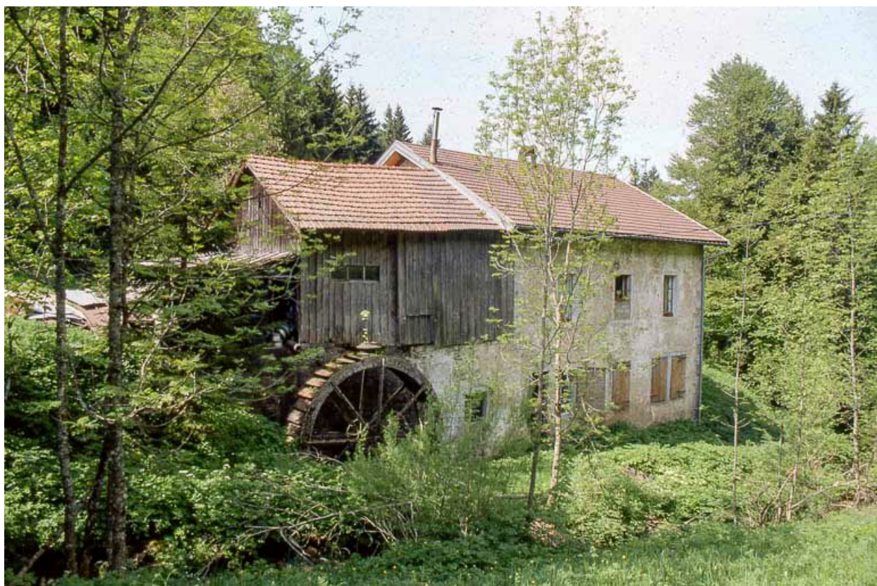
Façade postérieure et roue.
