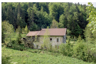
Façade postérieure, vue éloignée.
