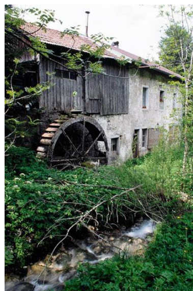
Façade postérieure, roue et bief Bruyant. Phot. Yves Sancey IVR43_19993900171ZA
