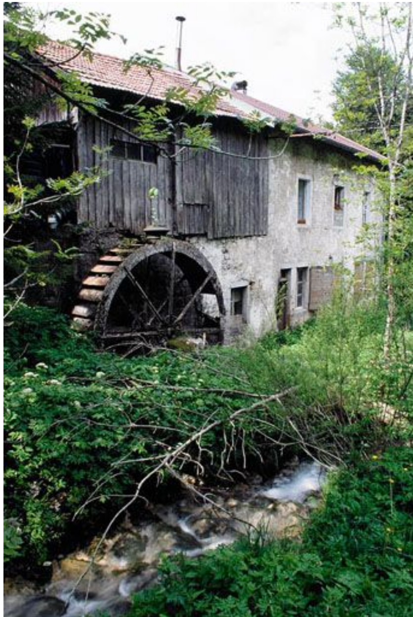
Façade postérieure, roue et bief Bruyant.
