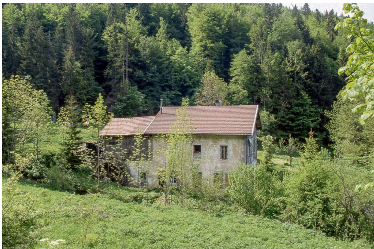
Façade postérieure, vue éloignée.
