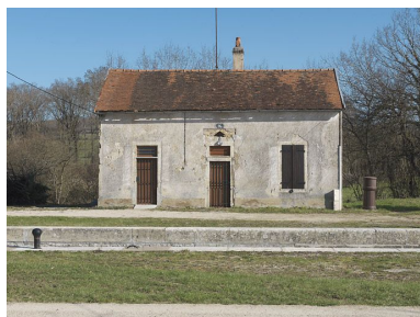
La maison éclusière de face. Phot. Thierry Kuntz IVR26_20122102769NUC4A
