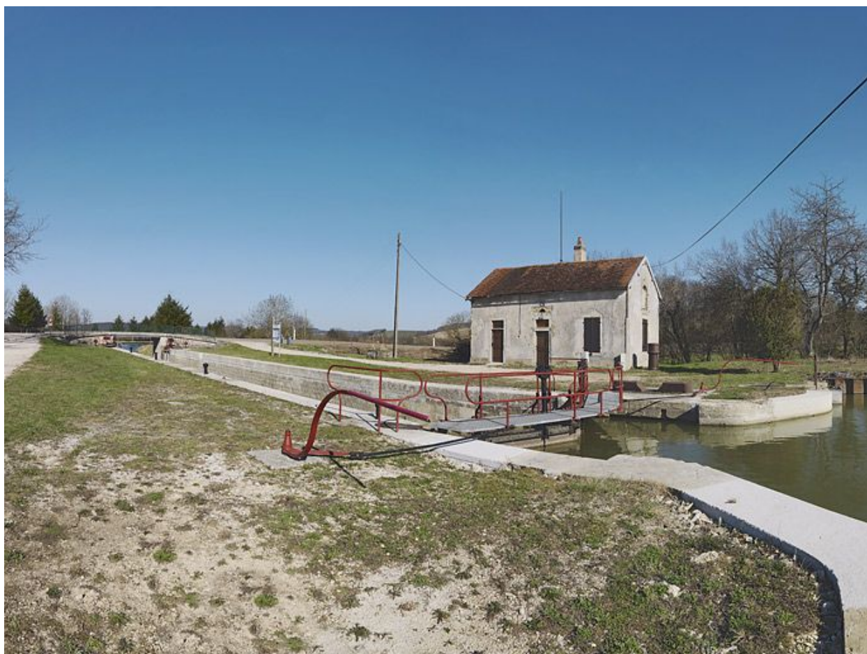
Le site d'écluse vu d'amont.
