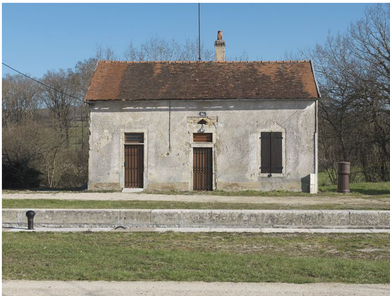
La maison éclusière de face.
