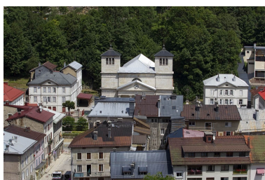
Le quartier de l'église. Phot. Yves Sancey IVR43_20103900670NUC2A
