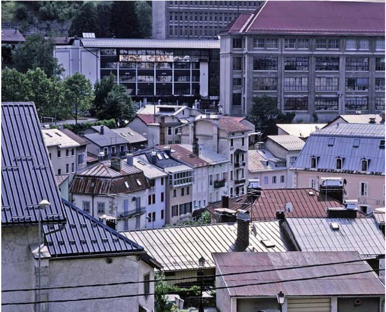
Toiture des bâtiments du quai Aimé Lamy.
