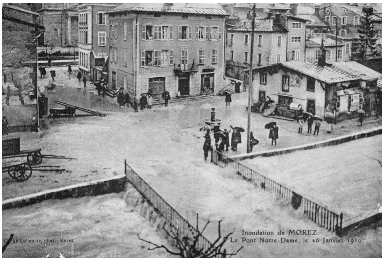
Inondation de Morez. Le Pont Notre-Dame, le 20 Janvier 1910.
