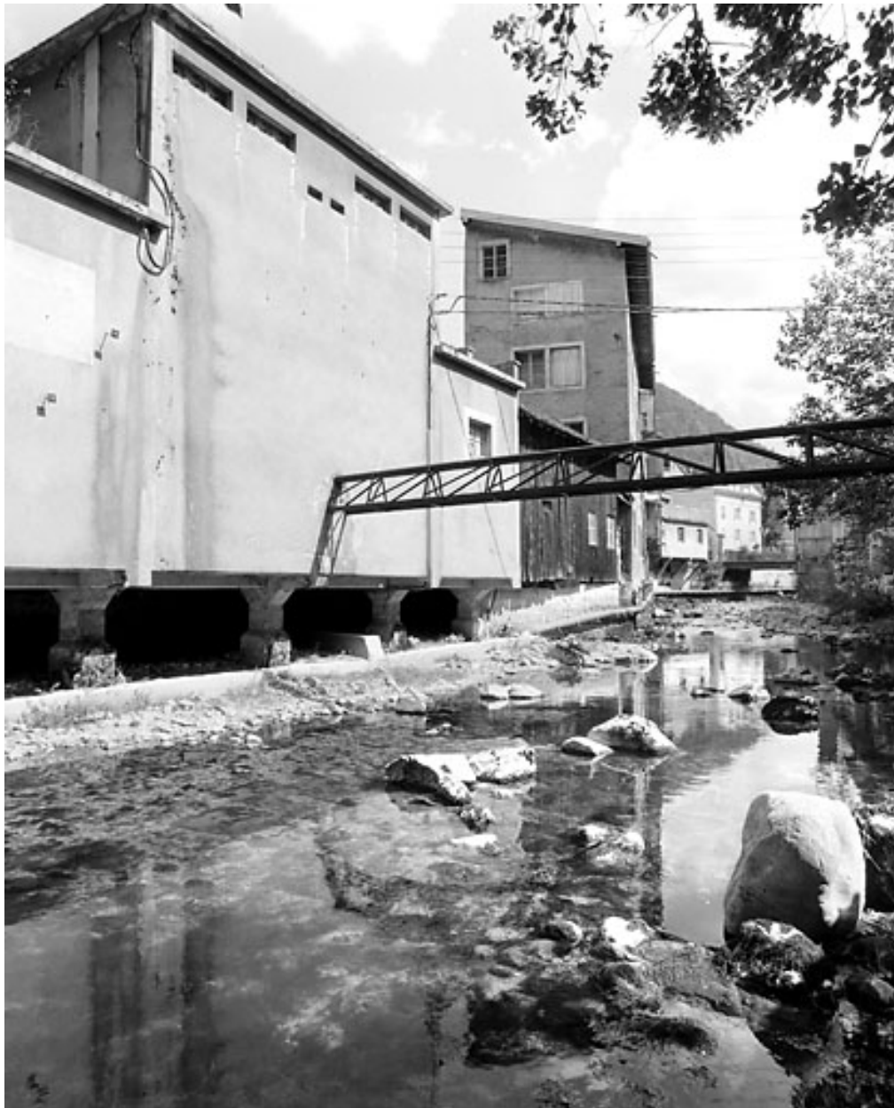
Façades arrière (sur la Bienne) des bâtiments aux n° 80 et 84 rue de la République.
