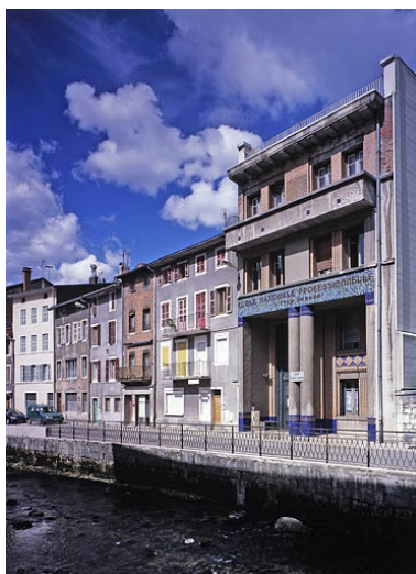
Le quai Aimé Lamy au niveau du lycée Victor Bérard. Phot. Yves Sancey IVR43_20033900987VA
