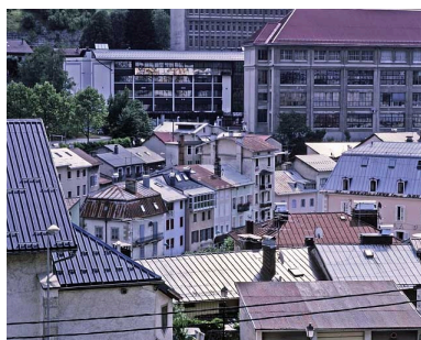
Toiture des bâtiments du quai Aimé Lamy. Phot. Yves Sancey IVR43_20033900633XA
