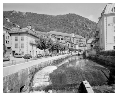
La Bienne et le quai Aimé Lamy, depuis la place Henri Lissac. Phot. Yves Sancey IVR43_20033900564V
