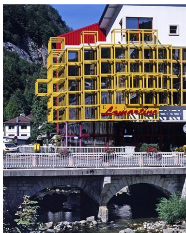
Pont Lamartine, depuis la rive gauche en amont. Phot. Yves Sancey IVR43_20033900329XA
