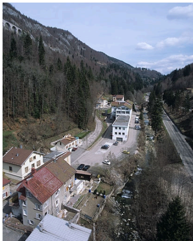
Le quartier de la cour du Roi et la vallée de l'Evalude, depuis le grand viaduc. Phot. Yves Sancey IVR43_20053900519XA
