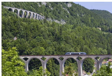
Le grand viaduc, avec celui des Crotes en arrière- plan (vue rapprochée). Phot. Yves Sancey IVR43_20103900577NUC2A
