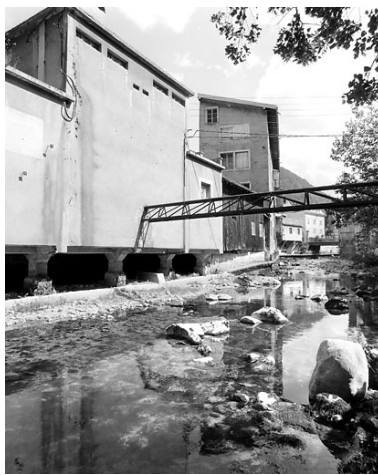
Façades arrière (sur la Bienne) des bâtiments aux n° 80 et 84 rue de la République. Phot. Yves Sancey IVR43_20033900254X
