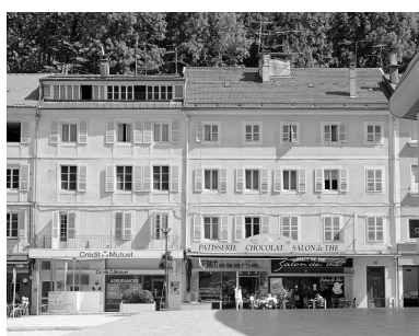
Façade antérieure des immeubles aux n° 135 et 137 rue de la République. Phot. Yves Sancey IVR43_20033900314X
