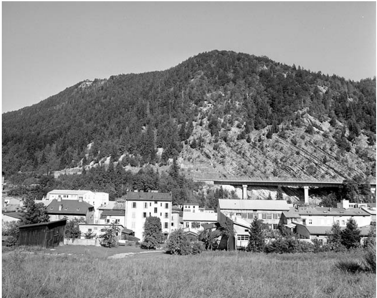
Le quartier de l'école du Haut et le rocher de Larce. A droite, élévation postérieure des bâtiments de la Société des Lunetiers.
