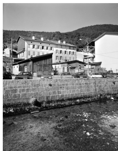
Elévation côté quai Jobez (n° 30 à 34) des immeubles aux n° 3 et 5 rue Pasteur. Phot. Yves Sancey IVR43_20033900864V
