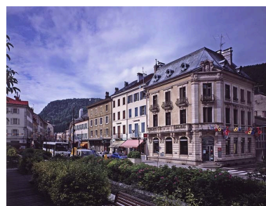
La rue de la République à l'angle de la rue Ernest Merlin. Phot. Yves Sancey IVR43_20033900786VA
