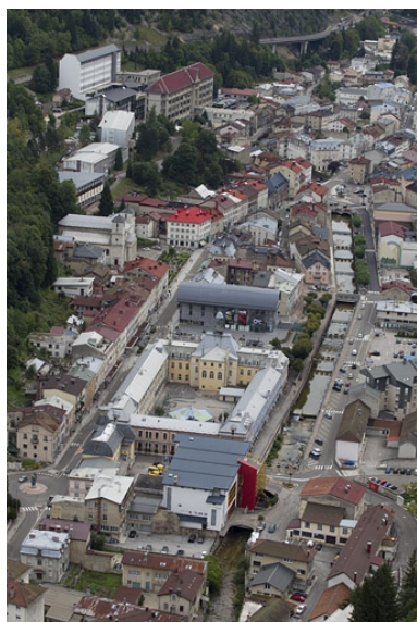
Vue d'ensemble plongeante sur les quartiers de l'hôtel de ville et de la place Henri Lissac, depuis le nord. Phot. Yves Sancey IVR43_20103900344NUC2A
