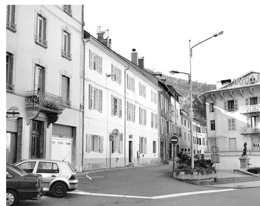
La rue Victor Hugo vers le n ° 32, près de son débouché sur la rue de la République. Phot. Yves Sancey IVR43_20033900432X
