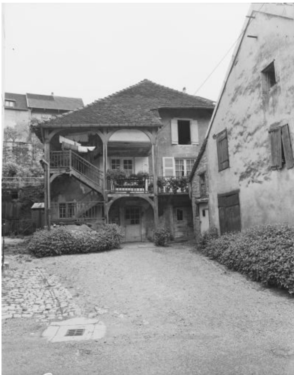
Maison située rue de la Vieille Eglise.
