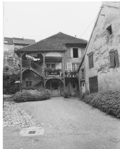
Maison située rue de la Vieille Eglise.
