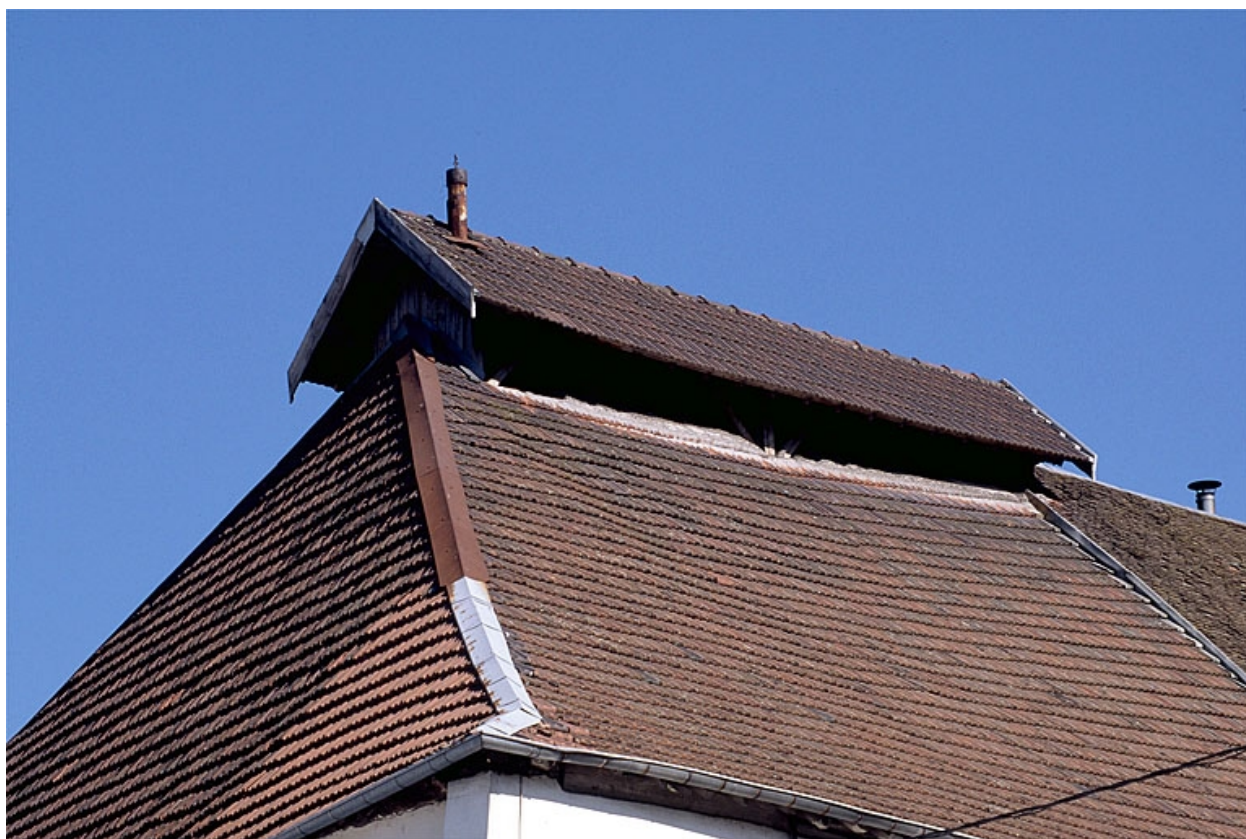
Atelier de fabrication : détail de la toiture.
