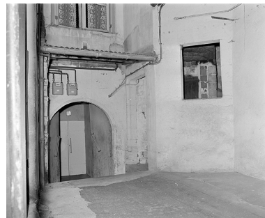
Porte d'escalier. Phot. Yves Sancey IVR43_19853900309X
