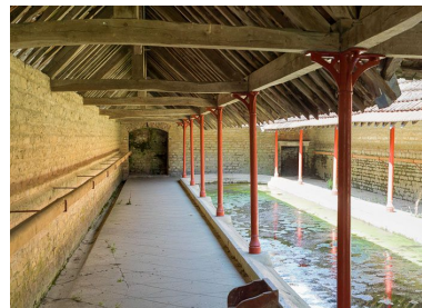
Vue de l'intérieur et des colonnes en fonte soutenant la toiture en impluvium. Phot. Pierre-Marie Barbe-Richaud IVR26_20138900040NUC4AQ
