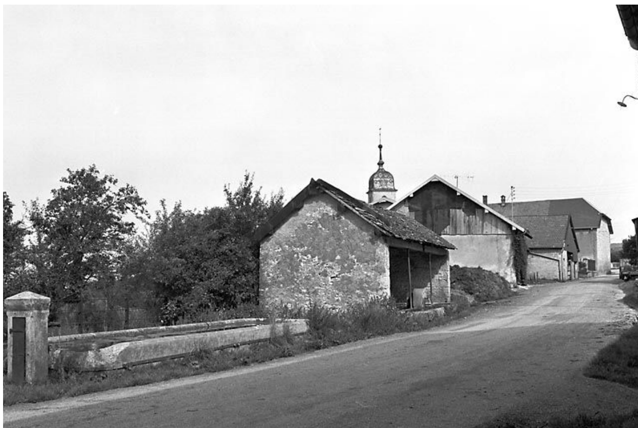
La fontaine-lavoir située rue de l'Eglise.
