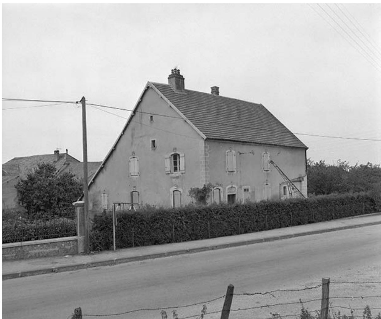
Maison située rue des Fontaines.
