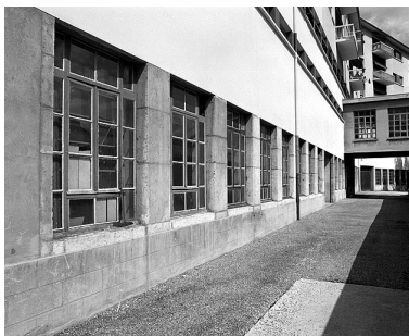
Façade postérieure : baies du
