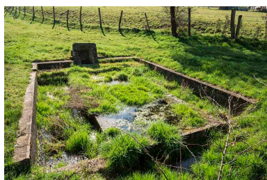
Lavoir, quartier des Gravieres. Phot. Jérôme Mongreville IVR43_20177000207NUC4A
