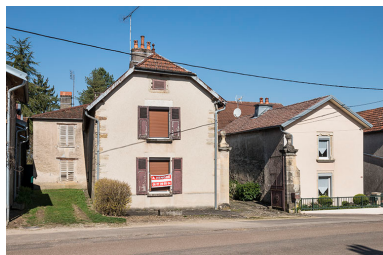
Vue sur l'usoir de la ferme. Phot. Jérôme Mongreville IVR43_20177000193NUC4A
