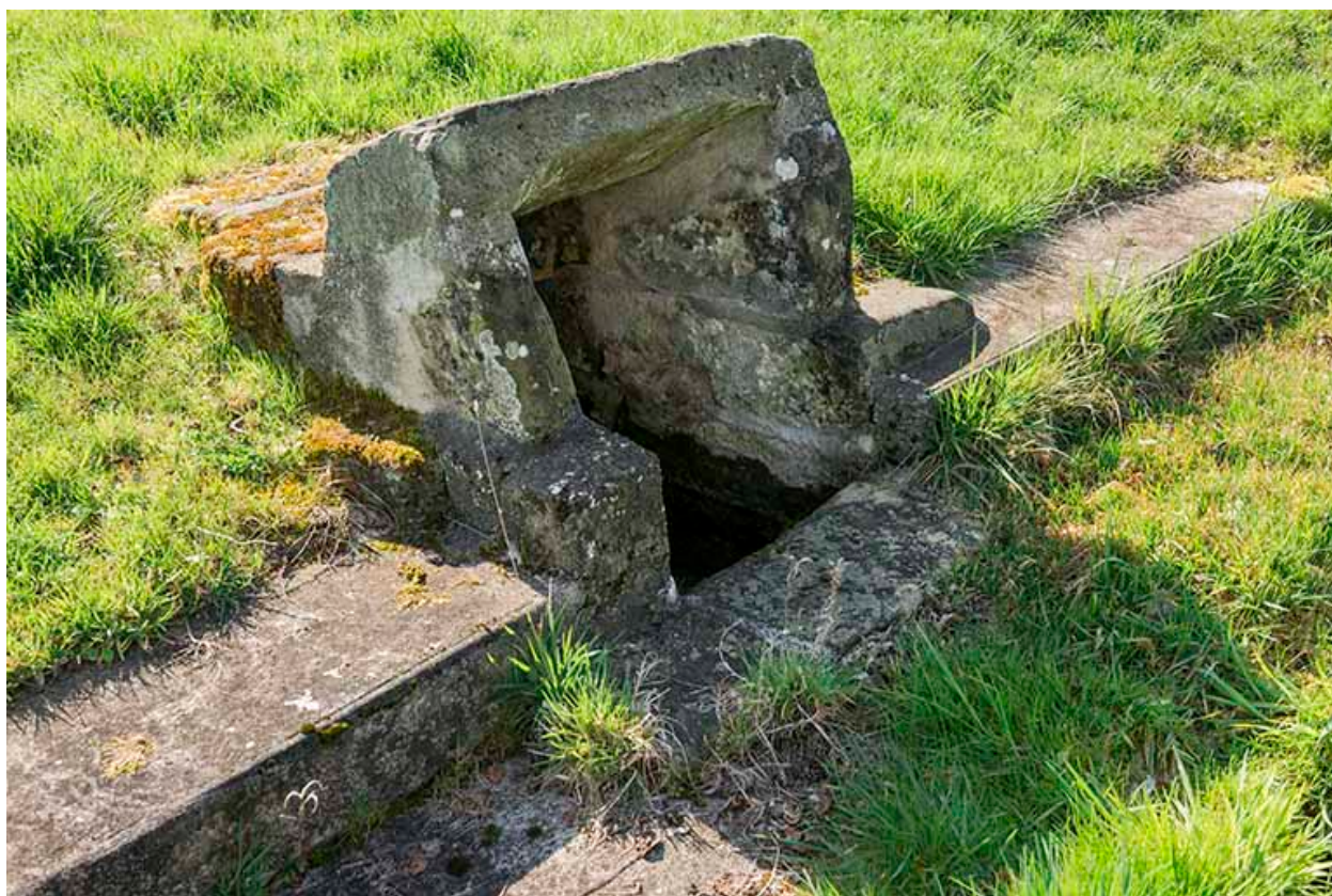
Fontaine d'alimentation du bassin.
