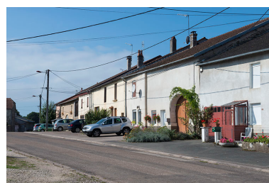
Vue générale, Grande rue. Phot. Jérôme Mongreville IVR43_20177000190NUC4A
