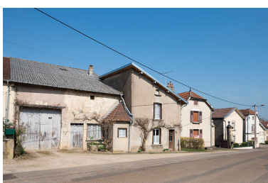
Vue générale, Grande rue. Phot. Jérôme Mongreville IVR43_20177000203NUC4A
