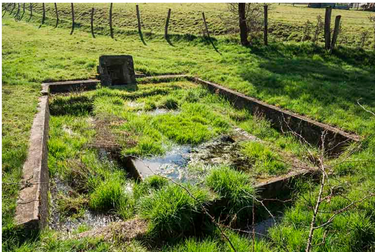
Lavoir, quartier des Graviers.
