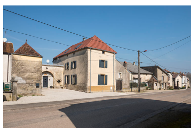
Vue générale, Grande rue. Phot. Jérôme Mongreville IVR43_20177000202NUC4A
